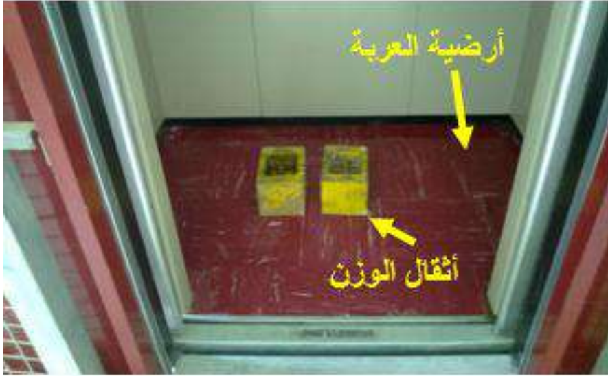
شكل 1- 34 وضع أثقال التوازن على أرضية العربة
