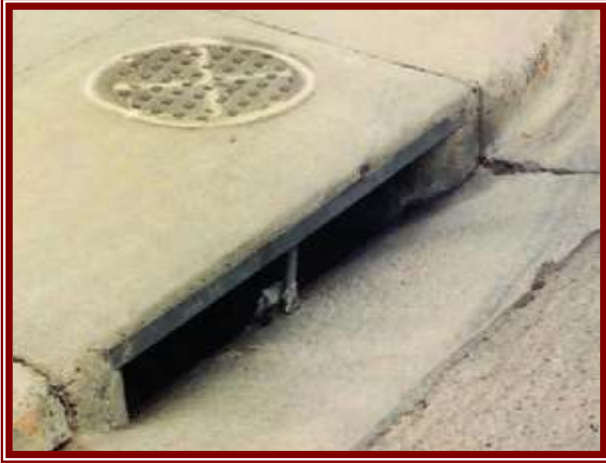
الشكل 10-21 مدخل مياه أمطار سطحي وجانبي
