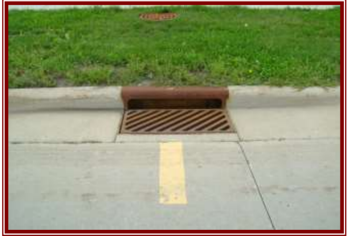
الشكل 10-21 مدخل مياه أمطار سطحي وجانبي
