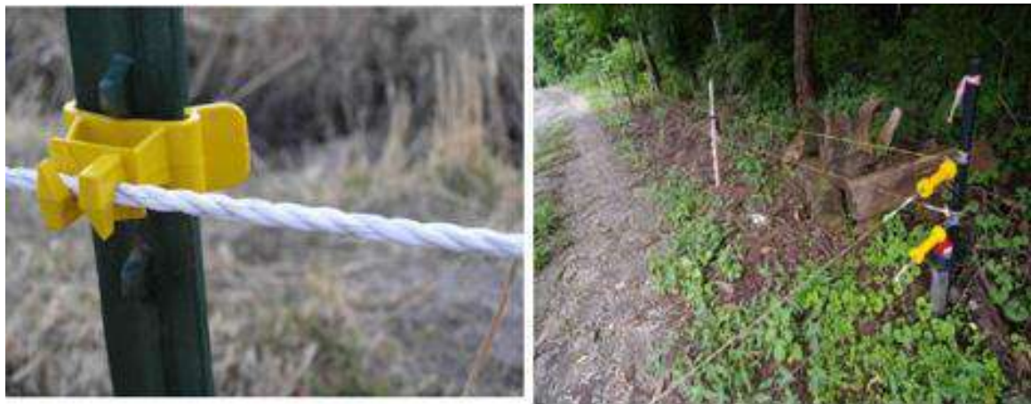
شكل 8-7: طريقة عزل الأسلاك بأعمدة الربط
