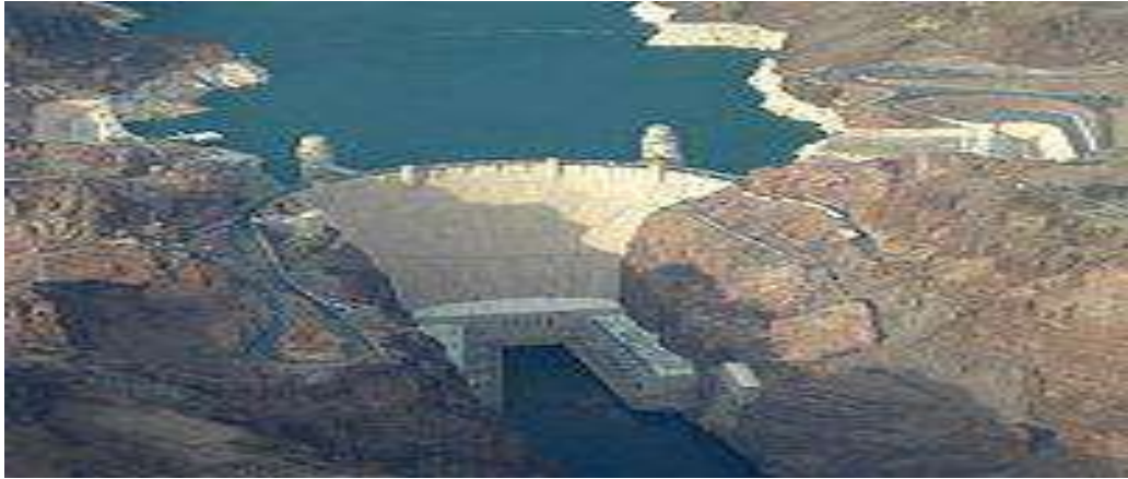
شكل ( 5 - 8 ) يوضح مياه مخزنة لتوليد الطاقة الكهربائية
