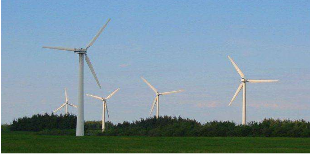
شكل ( 5 - 10 ) يوضح مجموعة أبراج لتوليد الطاقة الكهربائية بقوة الرياح
