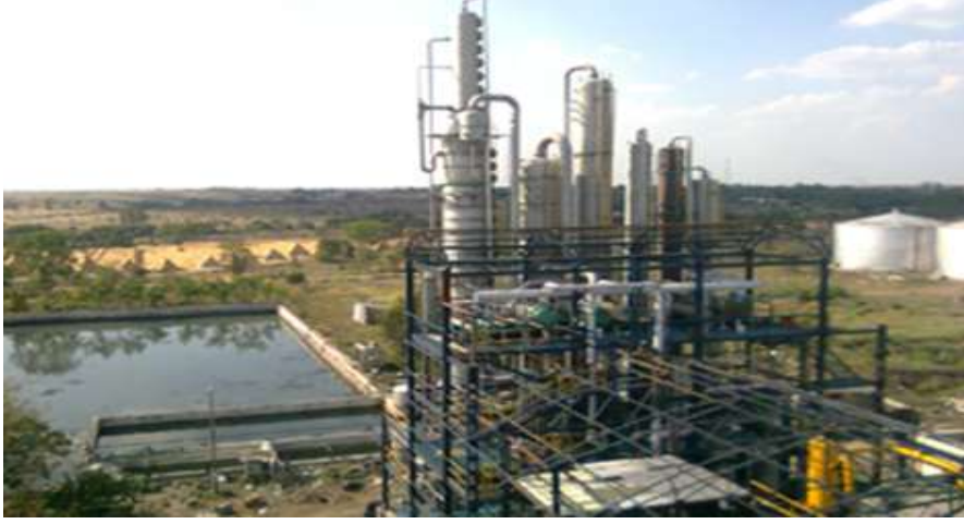
شكل (39) أبراج تقطير الكحول في المصانع الكبيرة
