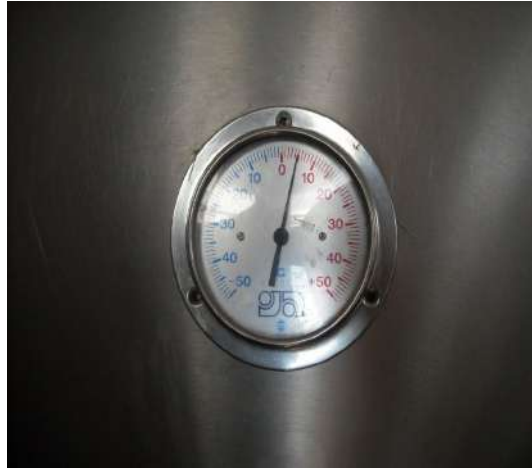
الشكل ( 59 ) خزانات الحليب المجهزة بمحرار خارجي للسيطرة على درجة حرارة الحليب
