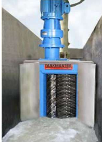
شكل(3.14): مقطع في إحدى الساحنات
