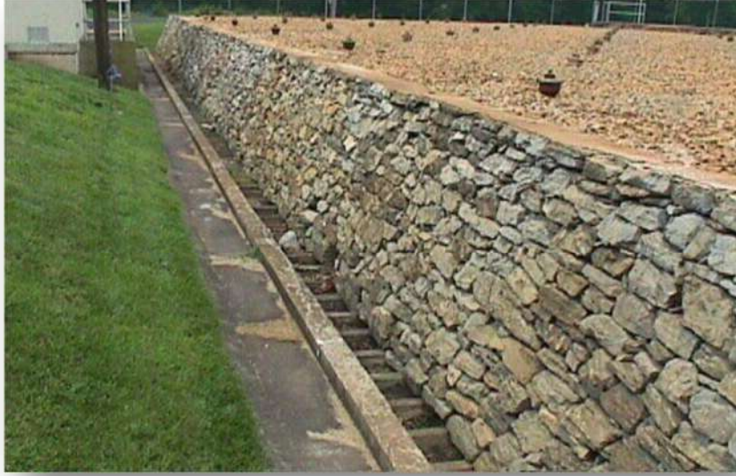
شكل (17-8) منظر جانبي لمنظومة التجميع للمرشح الحيوي.
