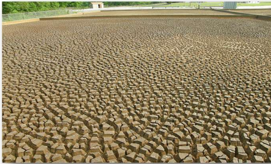
الشكل (2.22) : أسطح الرمل المستخدمة في تجفيف الحمأة
