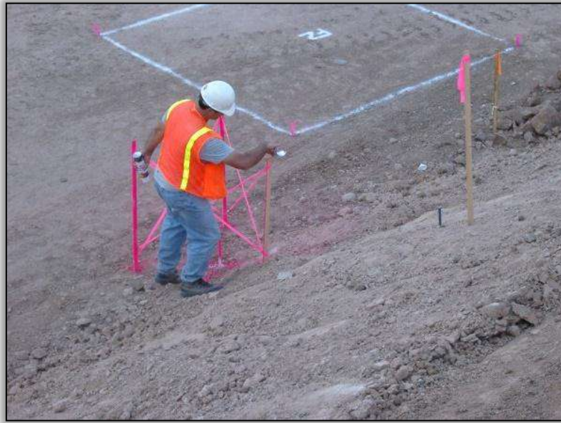
الشكل (11-1) مسح قطعة ارض وتعيين نقاط الضبط الارضية.
