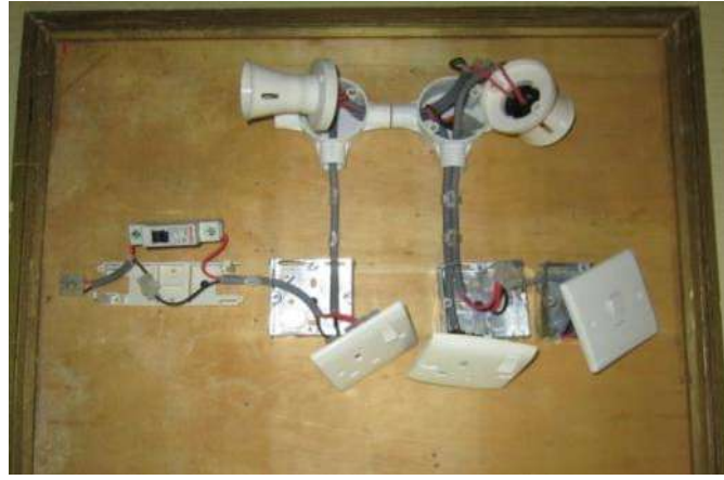
الشكل (4-36) توصيل نهايات الكيبلات الى العناصر الكهربائية
