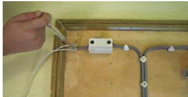
الشكل (19-4) الكشف عن القطب الحار بواسطة درنفييس الفحص
