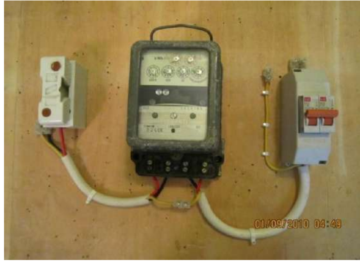
الشكل (4-51) توصل نهايات الكيبل الرئيسي الى العناصر الكهربائية للوحة القدرة.
