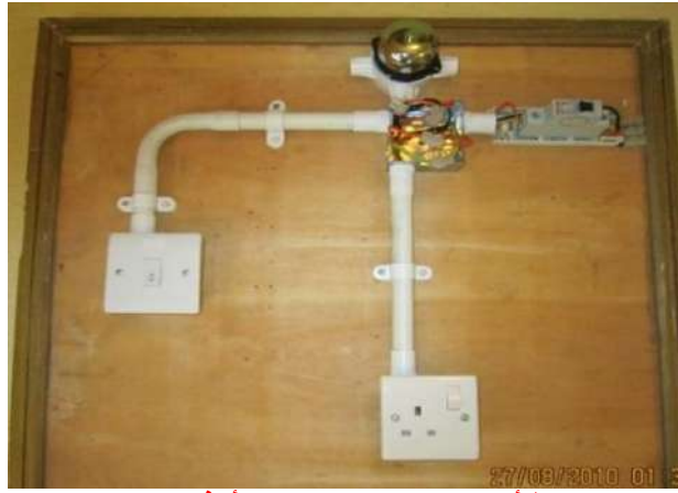
الشكل (26-4) ربط أسلاك دائرة الجرس والمأخذ الى العناصر الكهربائية
