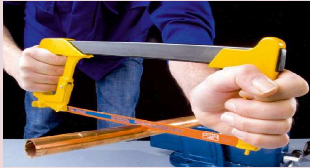
الشكل ( 5-6 ) قطع الأنابيب بواسطة المنشار اليدوي.
