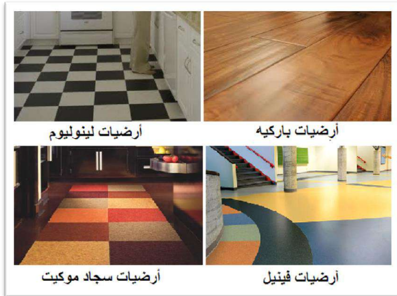
(شكل 10) مجموعة أنواع من التغليف للأرضيات تعمل على تخفيض مستوى الصوت
