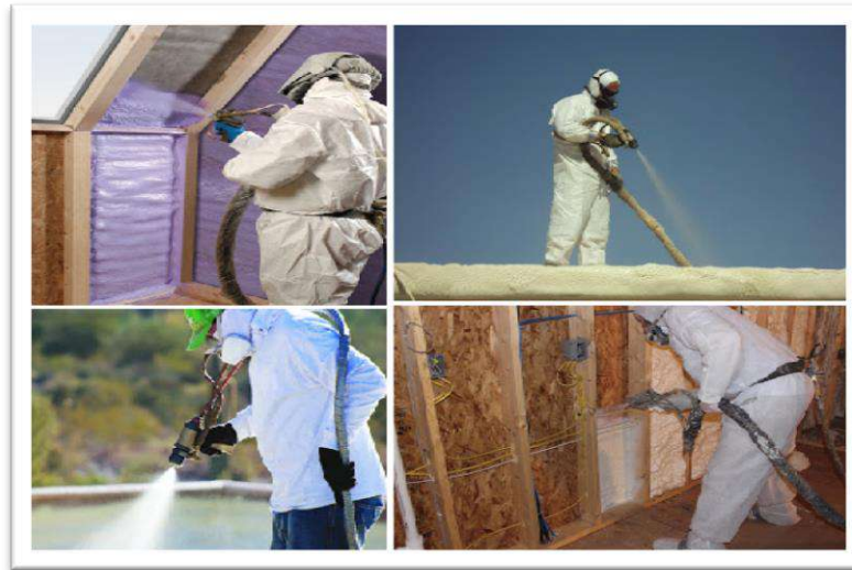
(شكل 2) طريقة عمل البولي يورثين
