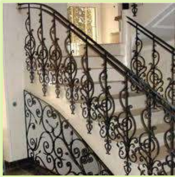
الشكل (1-6) يوضح المحجرات الحديدية
