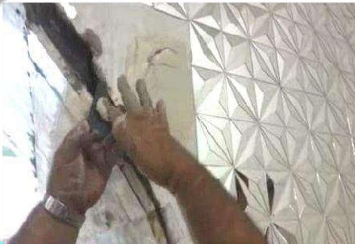
الشكل (6-49) تثبيت قطع المرآة المثلثة
