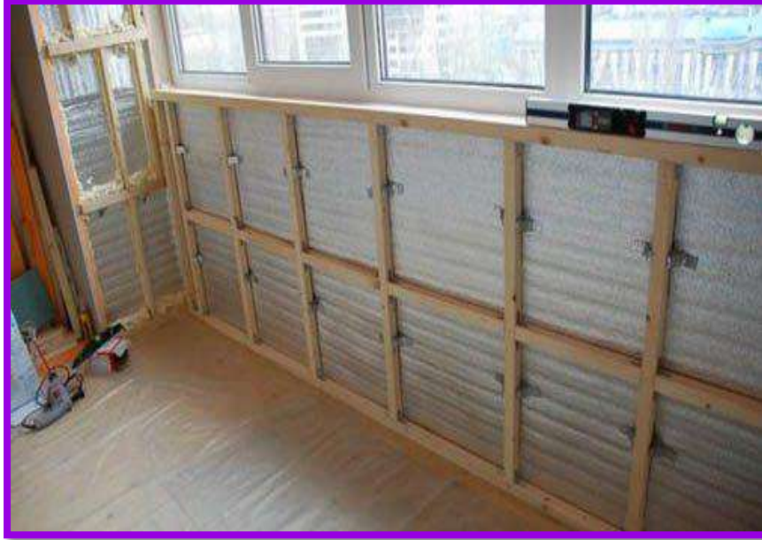
الشكل ( 4 - 3 ) طريقة تثبيت القواعد الخشبية على الجدران
