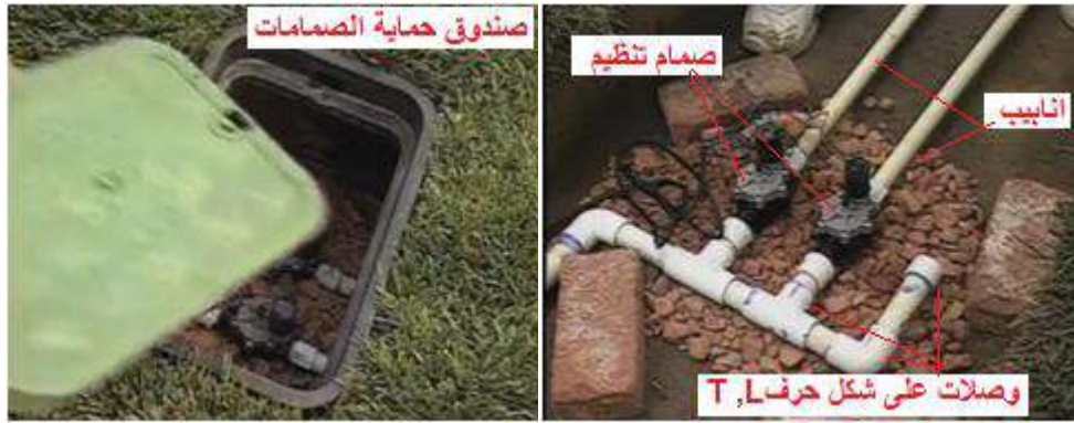
شكل 18-6 ربط الأنابيب بالمفاتيح
