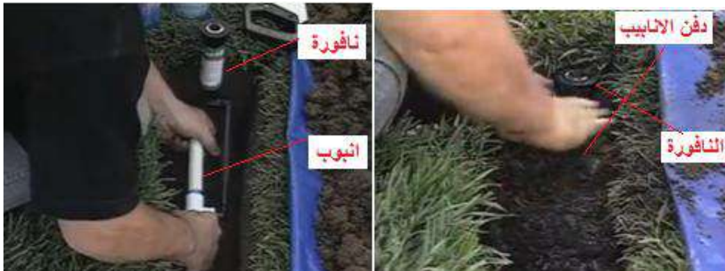
شكل 19-6 وضع النافورة مكانها ودفنها مع الأنابيب بالتراب
