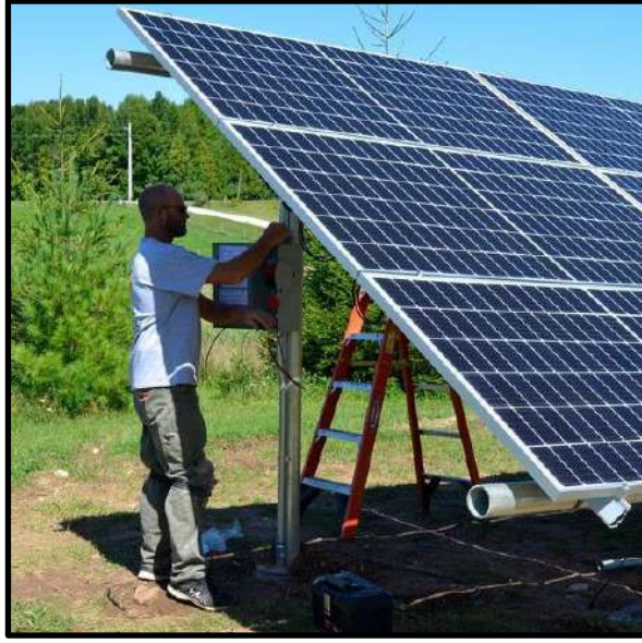
شكل (5-45) اطار تثبيت الألواح الشمسية
