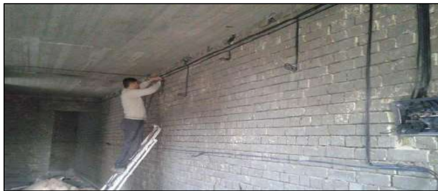
شكل (3-8) التأسيس الكهربائي تحت البياض
