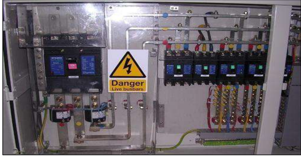
شكل (9-5) صيانة لوحات التوزيع الكهربائية
