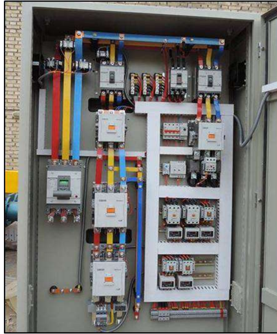
شكل (4-7) لوحة التوزيع الكهربائية
