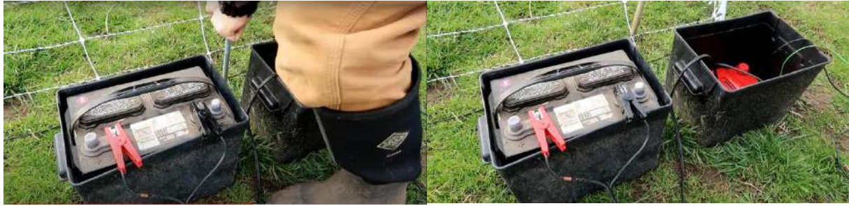
شكل (30-6) ربط قطبي بطارية الرصاص بالمنشط. شكل (31-6) تهيئة القطب الأرضي بغرس قضيب معدني بالأرض.
