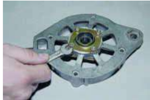
شكل(1-70) فتح براغي تثبيت كراسي المولد
