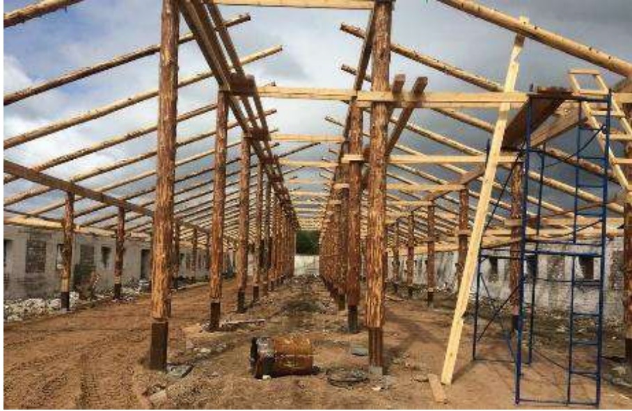
شكل (6-18) نصب الأعمدة في الأماكن المحددة لها
