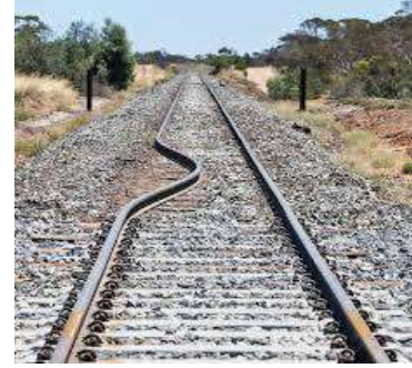
شكل (45-2) الالتواء في سكة القطار
