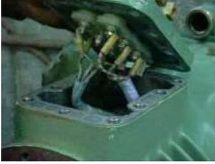
10- رفع لوحة الربط الكهربائي
