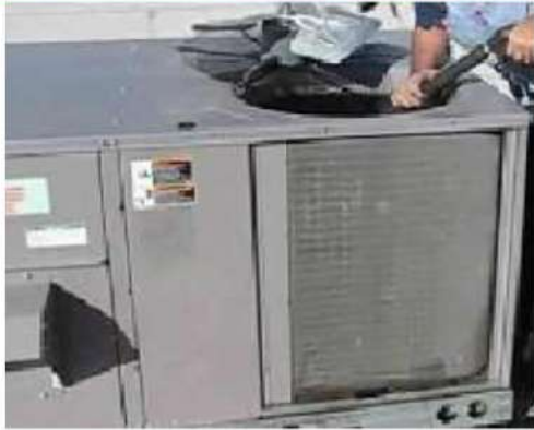
2- استخدام الماء المندفَع لتنظيف المكثف من الداخل
