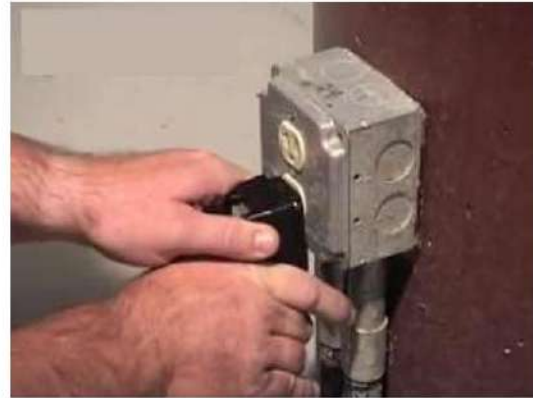
3- ربط المصدر الكهربائي
