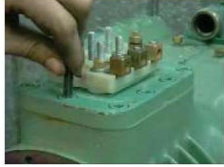
9- فتح لوحة الربط الكهربائي
