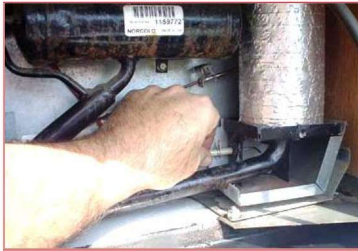
شكل 7-7 جهاز اشعال الثلاجة الامتصاصية
