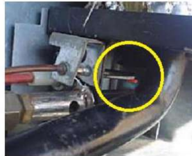
3- وجود اللهب الأزرق وتوهج المزدوج الحراري يدل على سلامة منظومة الاشتعال
