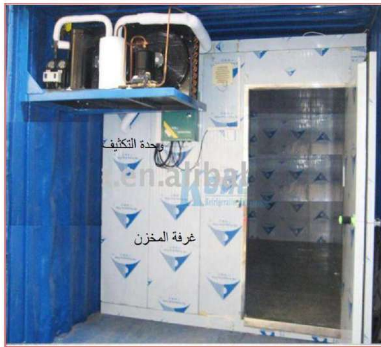
شكل 5-6 مخزن مبرد أو مجمد مبين فيه وحدة التكثيف وكيفية نصبها خارج الغرفة
