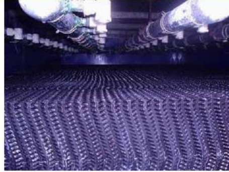
11- حشوة برج التبريد بعد التنظيف
