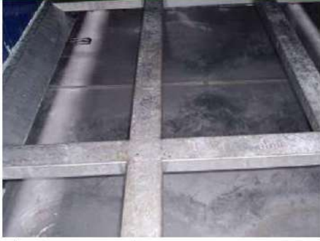
12- قاعدة حوض برج التبريد بعد التنظيف
