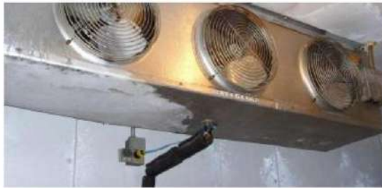
8- شكل أنبوب التصريف بعد عزله حرارياً
