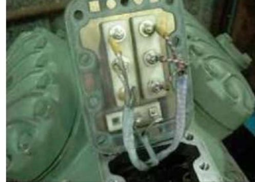
11- فتح الربط الكهربائي لملفات الضاغط بلوحة الربط
