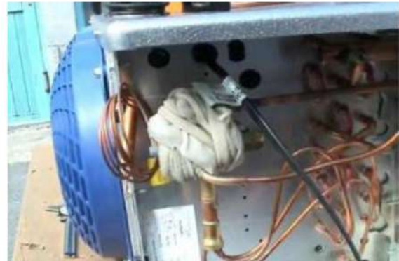
3- شكل الصمام بعد لف قطعة القماش المبللة
