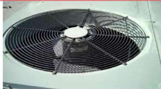
1- افتح اللوالب الثمان التي تثبت شبكة المروحة بجسم المكثف
