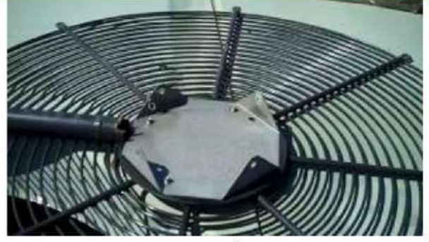
3- افتح اللوالب الأربعة التي تثبت المحرك الكهربائي بالشبكة
