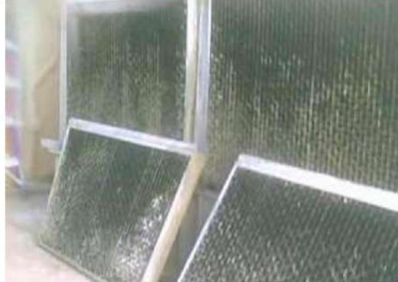
1- إرفع أجزاء حشوة برج التبريد
