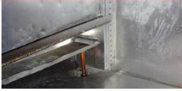
2- شكل المبخر بعد إزالة الجليد
