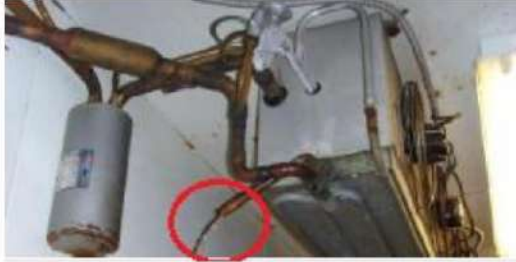
4- إزالة الأنبوب الثانوي الذي يربط مع أنبوب التصريف الرئيسي وترك الماء ينضج
