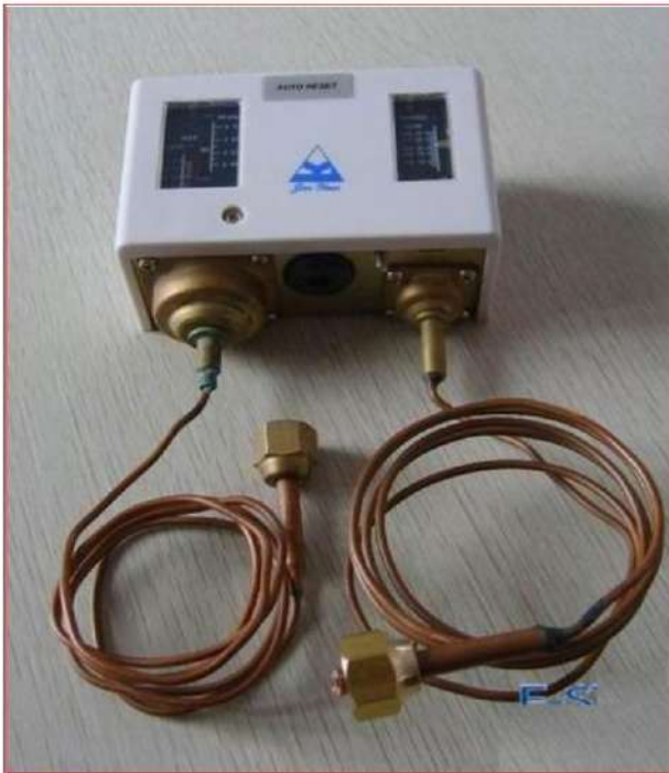
شكل 5-5 توصيل نهاية الأنبوبة الشعرية لقاطع حماية الضغط بصامولة ربط
