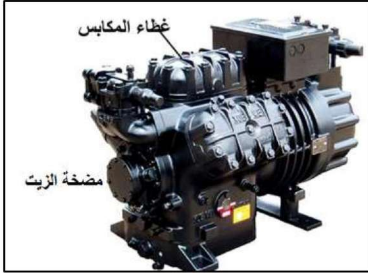
شكل 3-5 ضاغط نصف مغلق موضح فيه غطاء المكابس ومضخة الزيت
