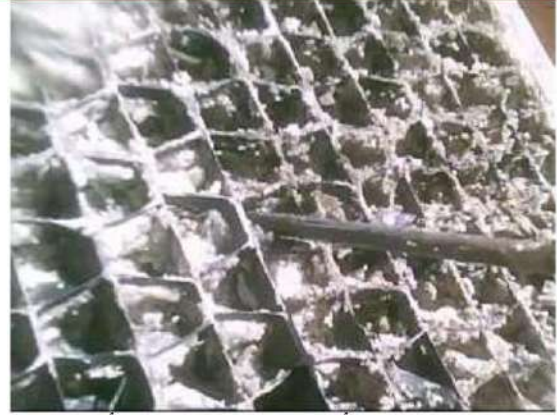
3- في حالة كون الأملاح كثيفة إستخدم أداة مناسبة لرفع الترسبات أولاً
