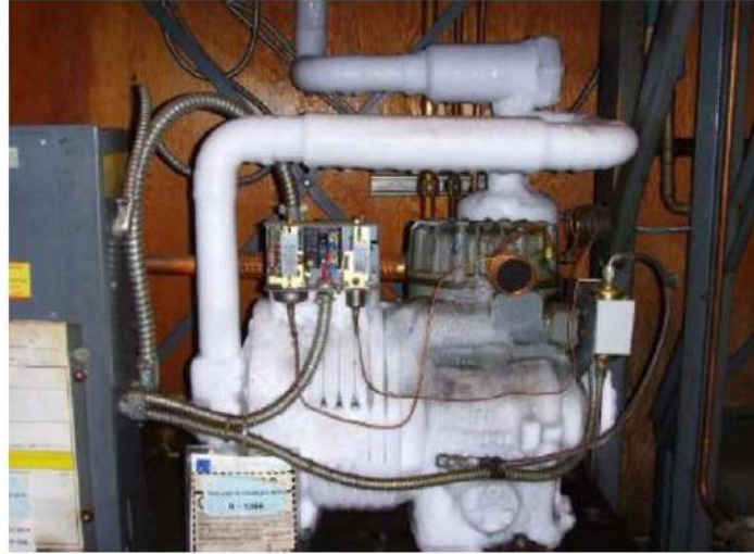
شكل 2-6 تكون الجليد على الضاغط بسبب عطل منظم درجة الحرارة وانسداد أنبوب تصريف الماء
