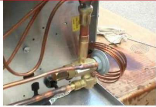
1- شكل صمام التمدد الحراري
