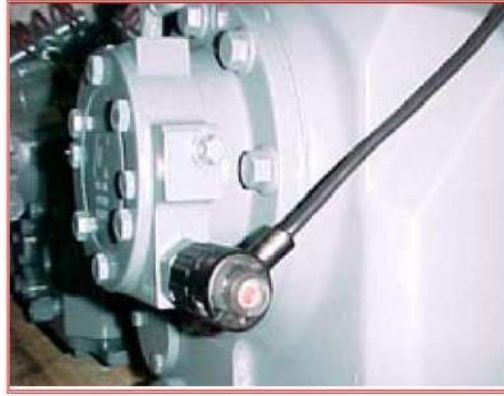
شكل 4-10 ربط قاطع وقاية انخفاض ضغط الزيت بالضاغط
