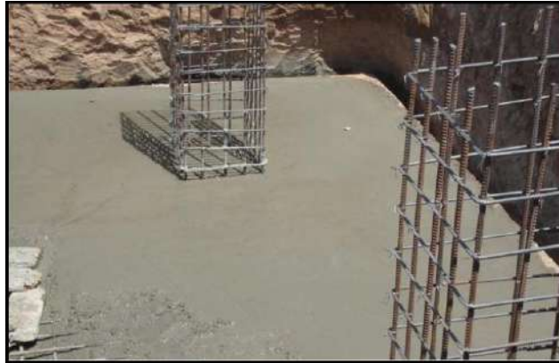
الشكل (٢-١٤) صب قاع حفرة البرج بالخرسانة الكونكريتية
