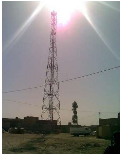
الشكل (٢-٢٣) إنهاء العمل ونصب البرج
