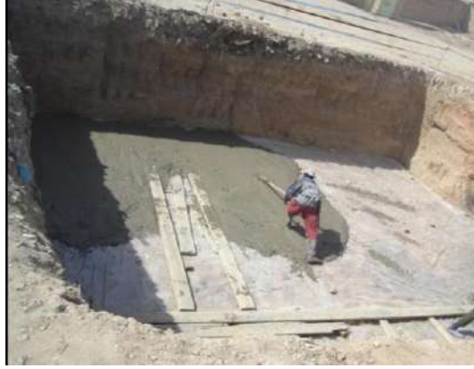
الشكل (٢-١١) عمل حفرة بعمق ٢.٥m أبعادها ضعف أبعاد قاعدة البرج
