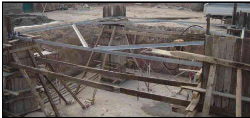
الشكل (٢-١٦) تركيب الهيكل الحديدي لقاعدة البرج بين مساند الأرجل
