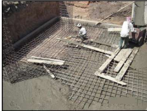
الشكل (٢-١٣) عمل هيكل من الحديد لتثبيت أرجل البرج فوقها
