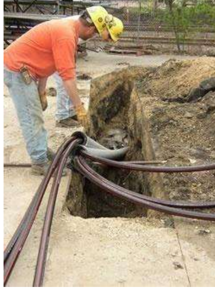
الشكل (٢-٦٩) تمديد الكيبلات المفردة داخل انابيب بلاستيكية
