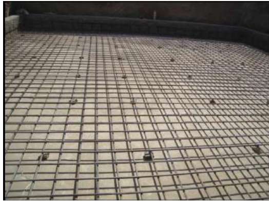
الشكل (٢-١٢) شبكة حديد التسليح في قاع حفرة برج الضغط العالي
