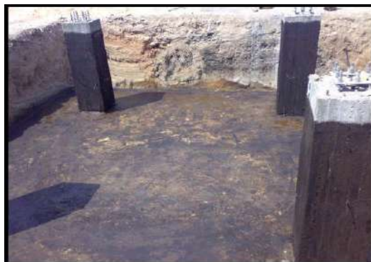
الشكل (٢-١٩) سكب الأسفلت المانع للرطوبة في حفرة البرج وعلى مساند أرجل البرج
