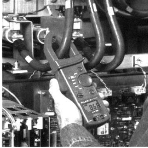
الشكل (١٧-٤) قياس تيار الأطوار الثلاث كدلالة على أئزان الأحمال
