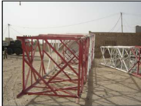
الشكل (٢-٢١) تهيئة البرج وفحصه لأجل تشبيده
