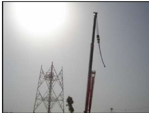
الشكل (٢-٢٢) استخدام الرافعة في نصب البرج
