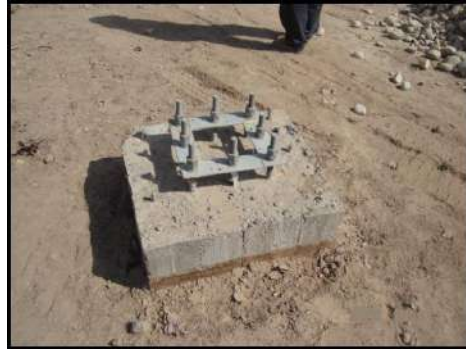
الشكل (٢-٢٠) ملى الحفرة بالتراب ومن ثم دكها ولا يظهر منها سوى رؤوس المساند
