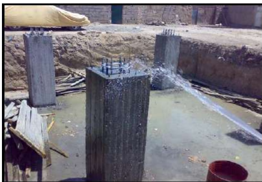
الشكل (٢-١٨) صب الخرسانة الكونكريتية لمساند أرجل البرج
