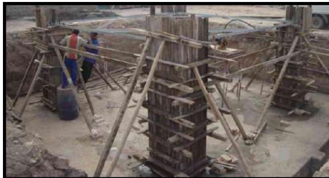
الشكل (٢-١٥) عمل قالب خشبي لمساند أرجل برج الضغط العالي
