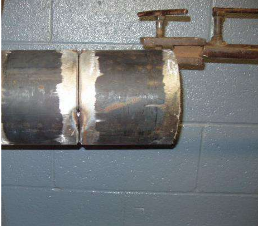
الشكل (١-٤٤) يوضح تثبت قطعتي الأنبوب بنقاط تثبيت وتعليقهما بماسك بارتفاع ملائم
