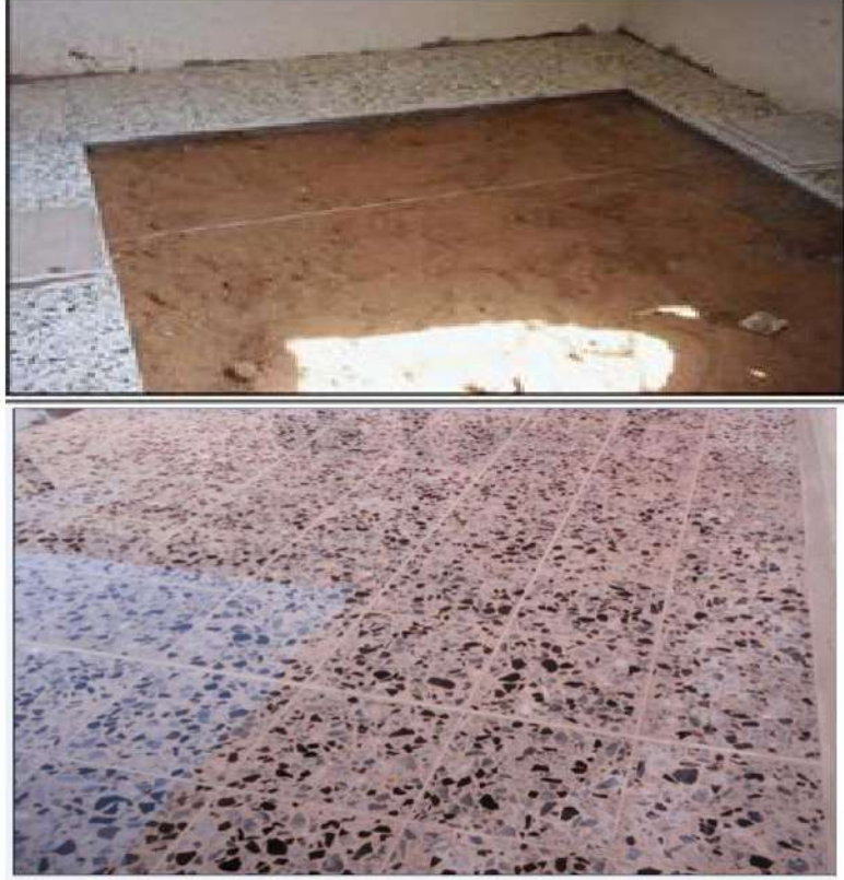
الشكل (6-8) يوضح عملية إنهاء التبليط بالكاشي
