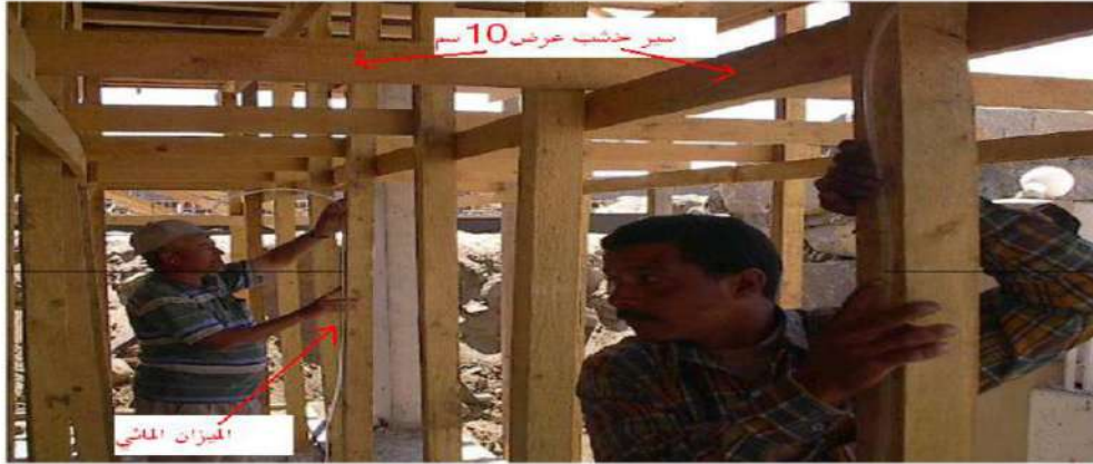
الشكل (4-6) يوضح عملية نقل الأوزان بواسطة الميزان المائي (الصوئدة)
