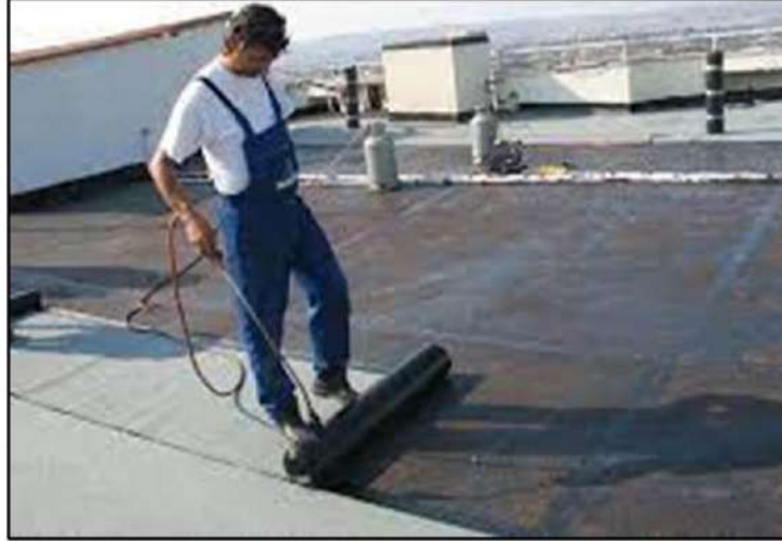
الشكل (4-7) يوضح عملية فرش اللباد الزيتي أو فرش طبقة النايلون والتداخل في عملية الفرش
