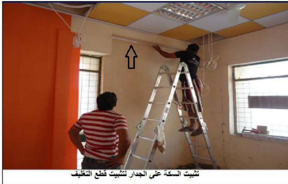
الشكل (7-15) طريقة استعمال القطع البلاستيك للتغليف الداخلي
