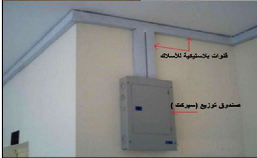
الشكل (7-20) يوضح التأسيس بالقنوات البلاستيكية
