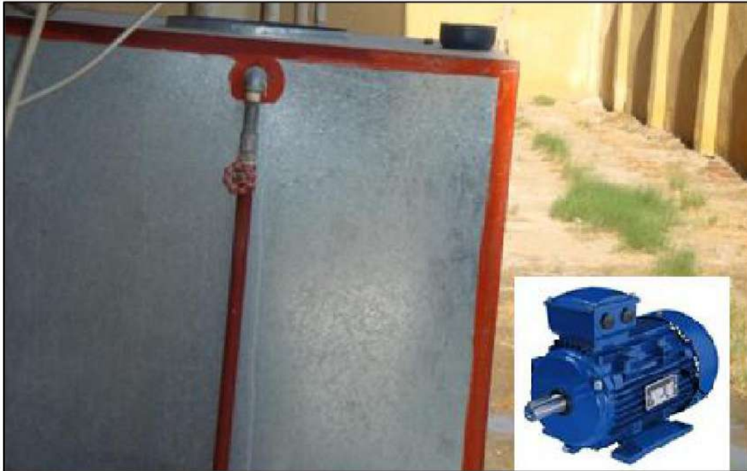
الشكل (17-7) خزان ماء من الصفائح المغلونة سعة 1 متر مكعب مع مضخة الماء
