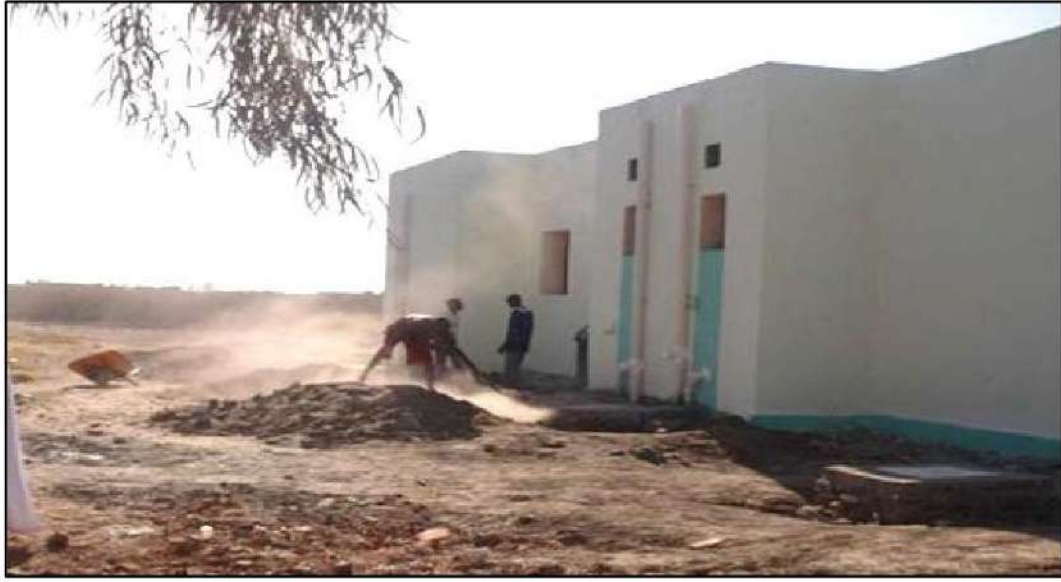
الشكل (10 - 9) عملية تنظيف موقع من بقايا مواد البناء
