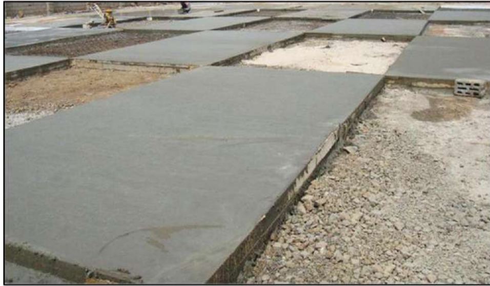
الشكل (6-20) يوضح الترتيب وصب الخرسانة
