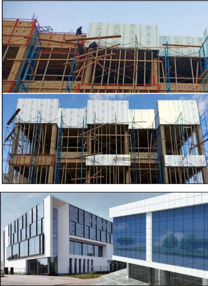
الشكل (7-10) يوضح طريقة تفاصيل الهيكل الحديدي للتغليف بالكوبون
