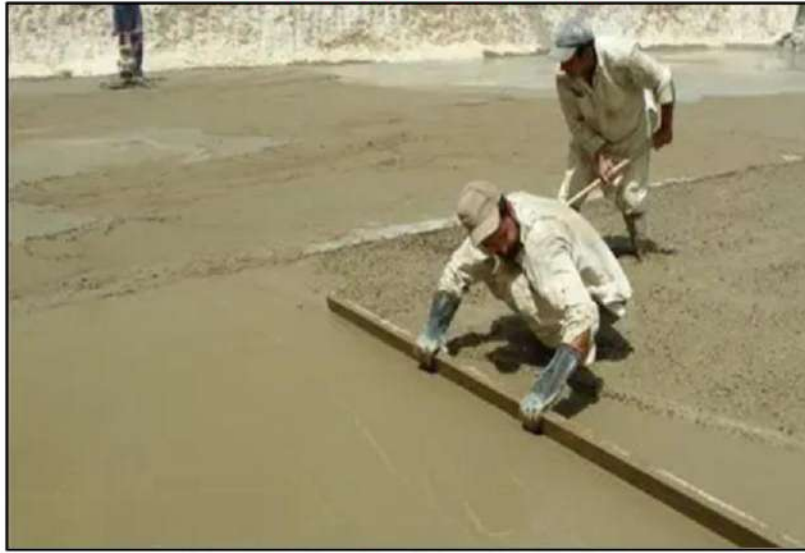
الشكل (6-14) عملية صقل سطح الخرسانة
