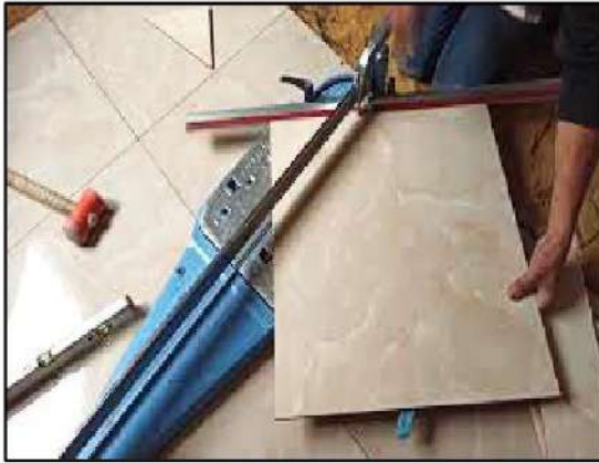
الشكل (7-14) يوضح قطع اليورسلين وأدوات القطع (المقص)
