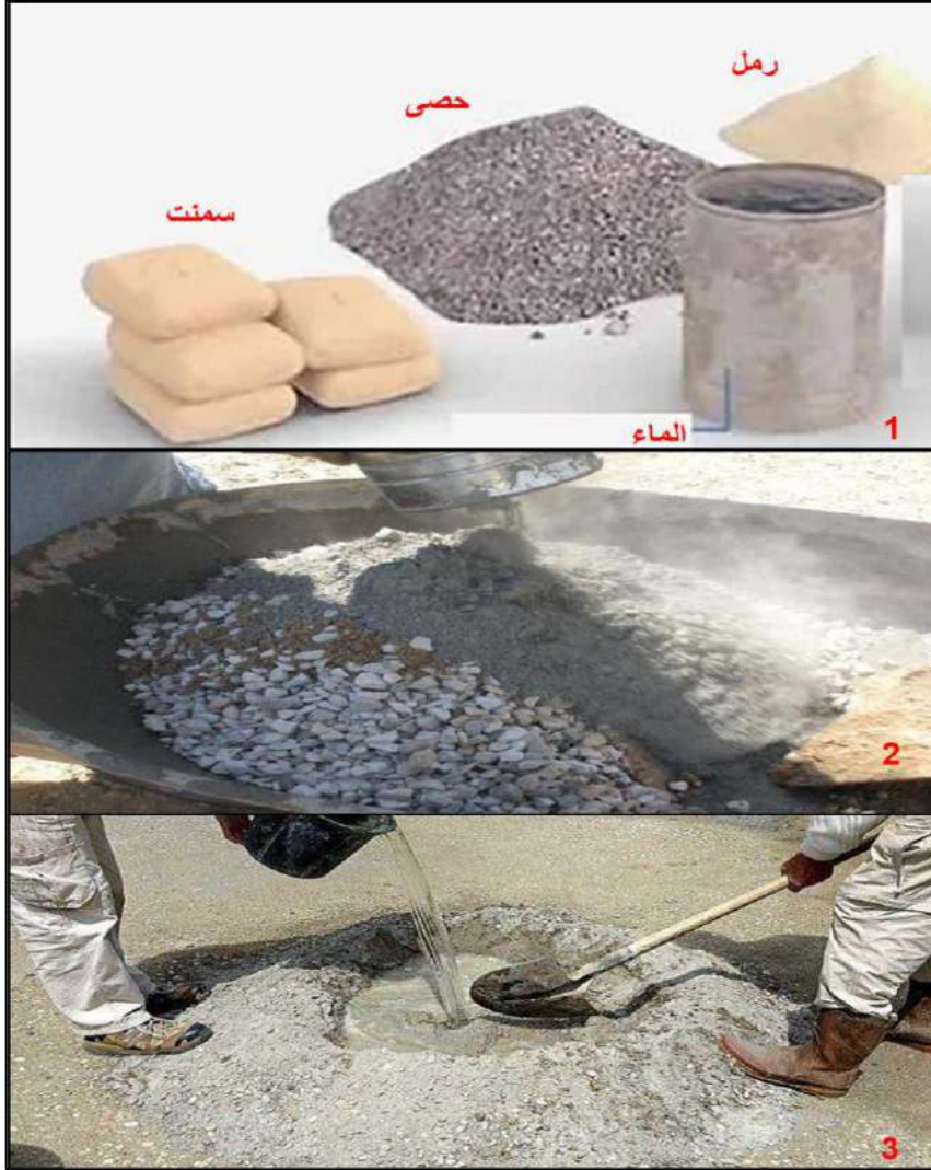
الشكل ( 2-1 ) يوضح طريقة الخلط اليدوي
