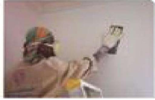
الشكل (7-8) يوضح عملية التنظيف والتنعيم لسطح الجدران
