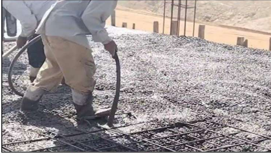
الشكل (6-13) كيفية توزيع ورص الخرسانة
