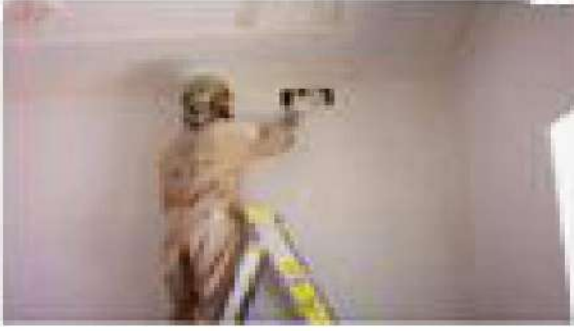
الشكل (7-8) يوضح عملية التنظيف والتنعيم لسطح الجدران
