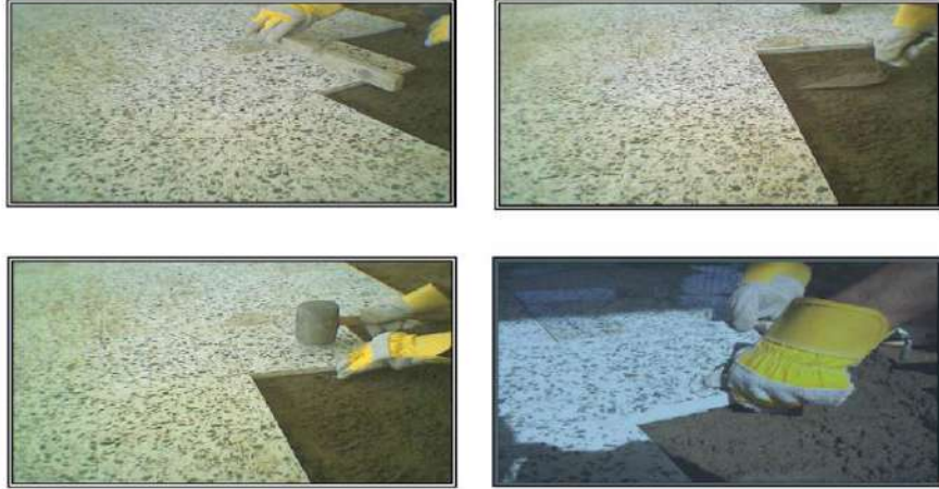
الشكل (4-8) يوضح عملية التبليط بالكاشي
