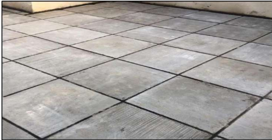
الشكل (6-7) طريقة كوي الماستك بين قطع الشتاكر
