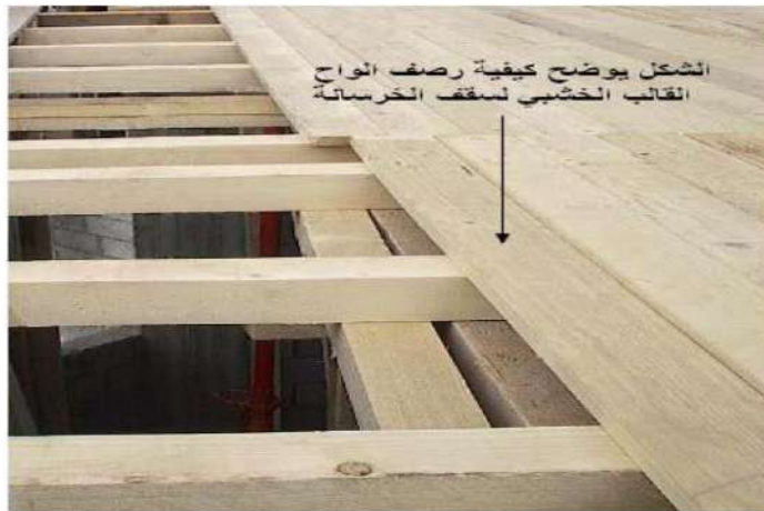
الشكل (1-6) كيفية رصف ألواح القالب الخشبي للسقف
