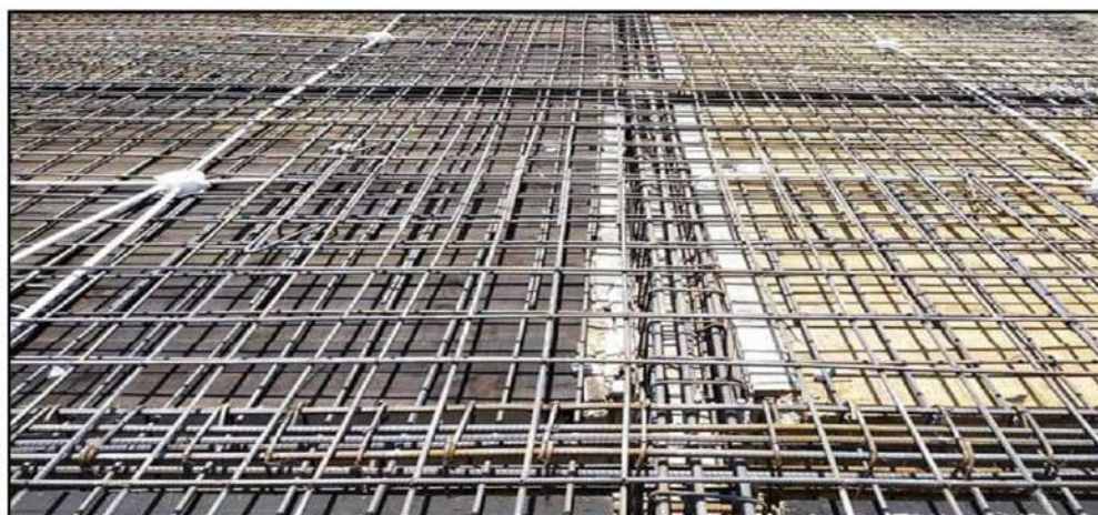
الشكل (10-6) يوضح فرش طبقة حديد التسليح للسقف
