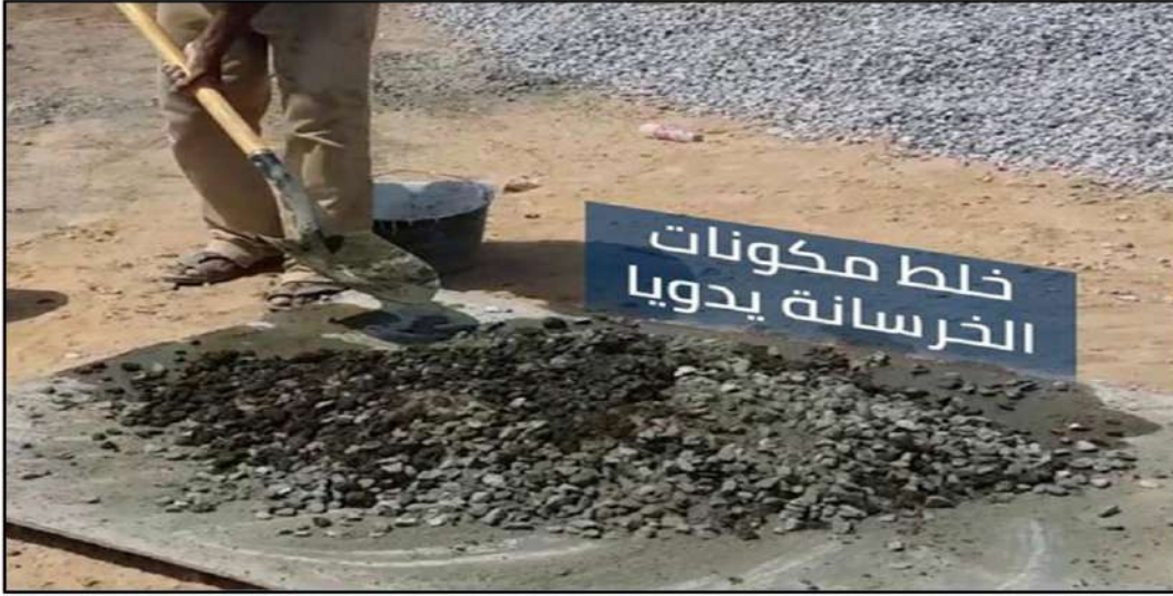
الشكل (4-4) اللوح (الجينكو) الذي يجري عليه عملية الخلط
