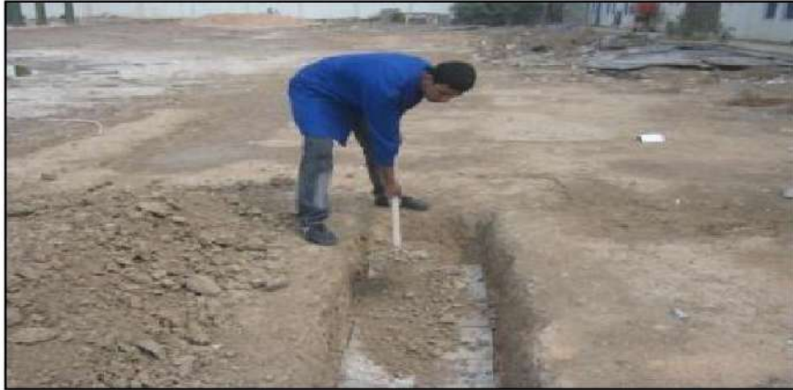
الشكل (17-1) احد الطلاب يقوم بحفر الأساس أثناء التدريب العملي بالكرك
