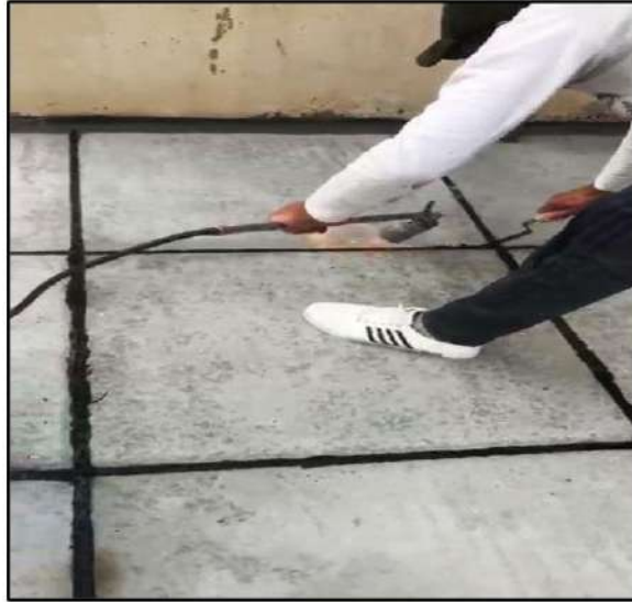
الشكل (6-7) طريقة كوي الماستك بين قطع الشتاكر
