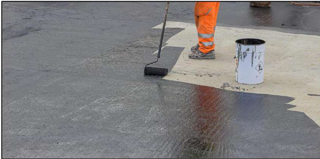
الشكل (2-7) يوضح طريقة تزفيت السطح بوساطة الفرشاة
