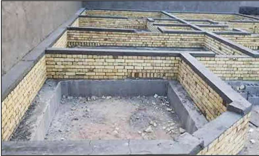
الشكل (4-5) يوضح صبة مانع الرطوبة فوق بناء الأساس
