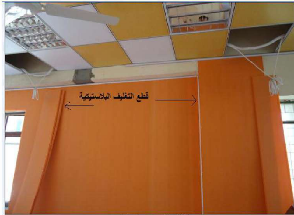
الشكل (7-16) طريقة استعمال القطع البلاستيك للتغليف الداخلي
