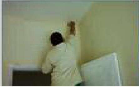
الشكل (7-8) يوضح عملية التنظيف والتنعيم لسطح الجدران
