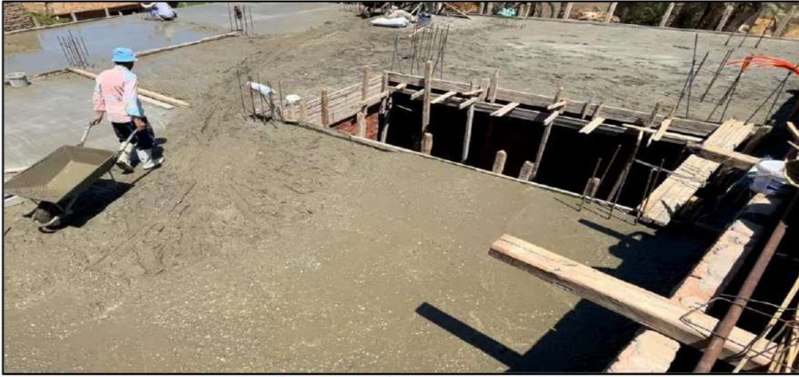
الشكل (6-11) يوضح عملية صب الخرسانة للسقف
