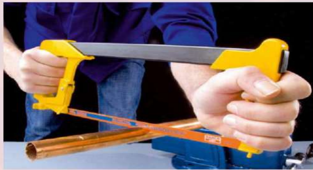
الشكل ( 5-6 ) قطع الانابيب بواسطة المنشار اليدوي.
