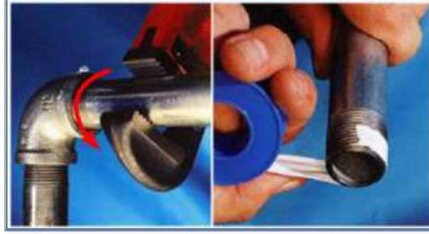
شكل 4-2 ج طريقة وضع شريط التفلون وربط الأنابيب
