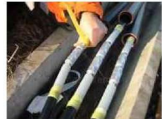
8- البدء بعزل أسطوانة الربط بعد كبسها
