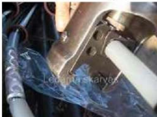
7- اضغط أسطوانة الربط بضغط هيدروليكي
