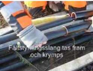
9- سحب العازل الحراري الأول الذي يتقلص بالحرارة
