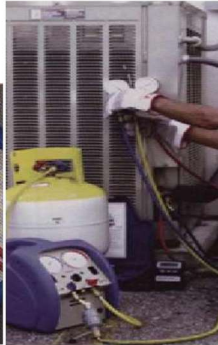
عملية إعادة تأهيل بخار مائع التثليج غمر أسطوانة إعادة تأهيل البخار في الثلج شكل 7- 27 طريقة إعادة تأهيل بخار مائع التثليج
