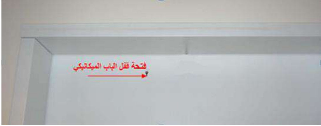
شكل (1 - 23) فتح الباب الخارجي بواسطة مفتاح القفل الميكانيكي
