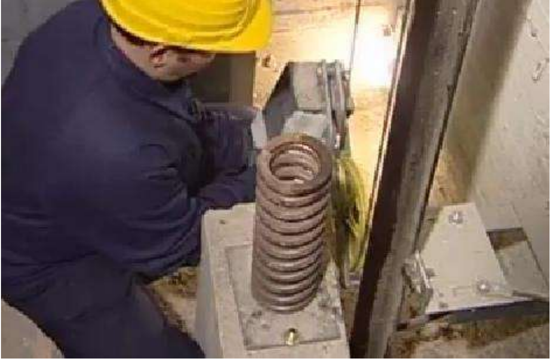
شكل (1 - 50) رفع بكرة الشد وتحرير الحبل من أخذود بكرة المحكم
