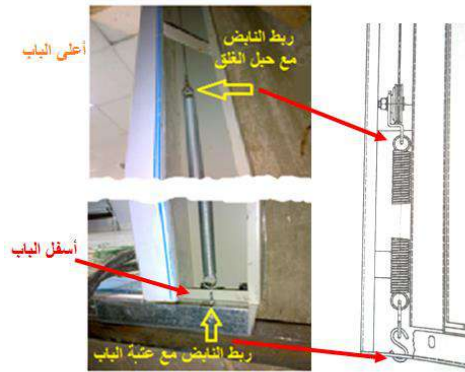
شكل (1 - 27) فحص نابض إعادة غلق الباب
