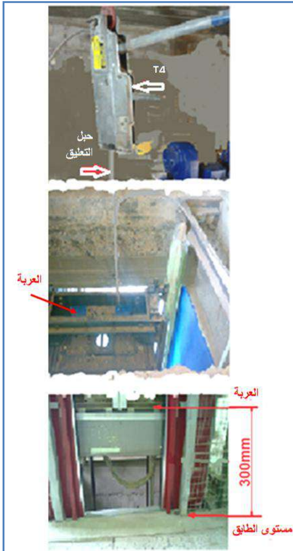
شكل (1 - 10) تعليق العربة بواسطة أداة التعليق (T4)
