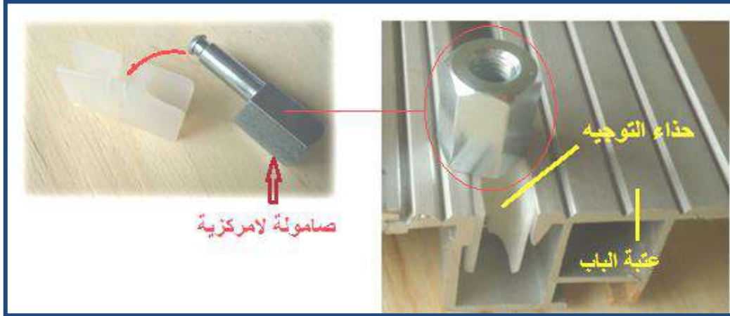
شكل (1 - 35) الكشف عن التآكل الحاصل في حذاء التوجيه لباب المصعد
