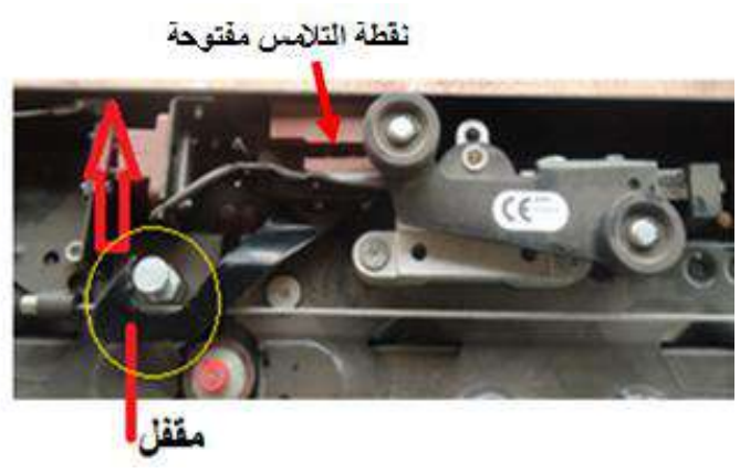
شكل (1- 31) فحص أنطباق خطاف قفل الباب ونقطتي التلامس الكهربائي
