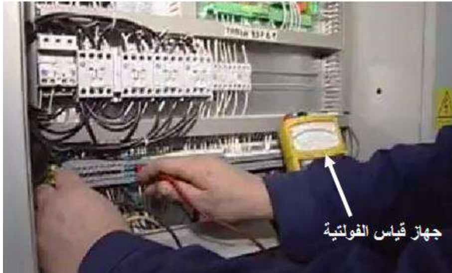
شكل (1 - 44) توصيل جهاز قياس الفولتية على التوازي مع طورين في دائرة محرك السحب
