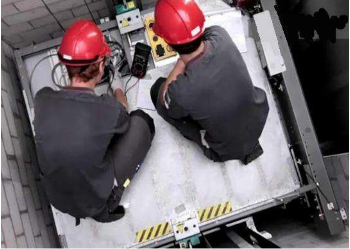
شكل (1-4) عمال الصيانة وهم جالسون فوق عربة المصعد لإجراء عملية الصيانة
