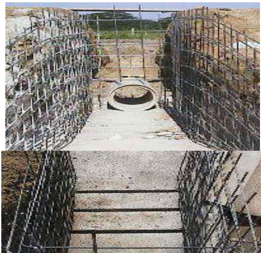
الشكل 3-6 أنشاء خابور الصرف في أحواض تربية الأسماك واجزائه .
