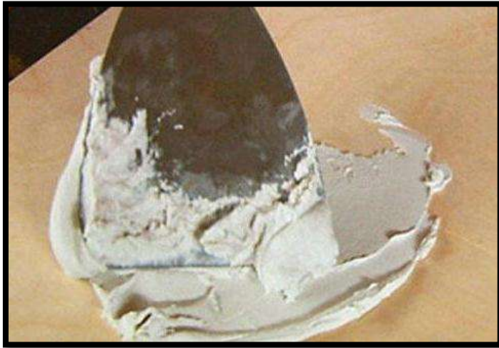
الشكل (1-65) يوضح علاج خدوش السطح الخشبي
