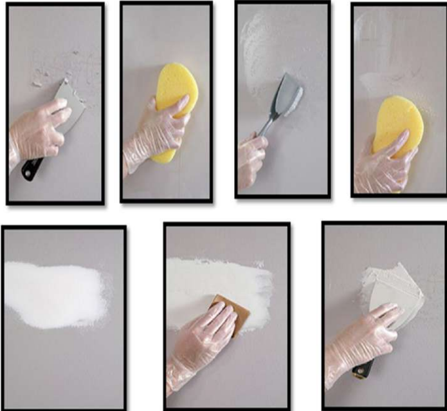
الشكل (10-2) معالجة وتنظيف الجدار قبل الطلاء
