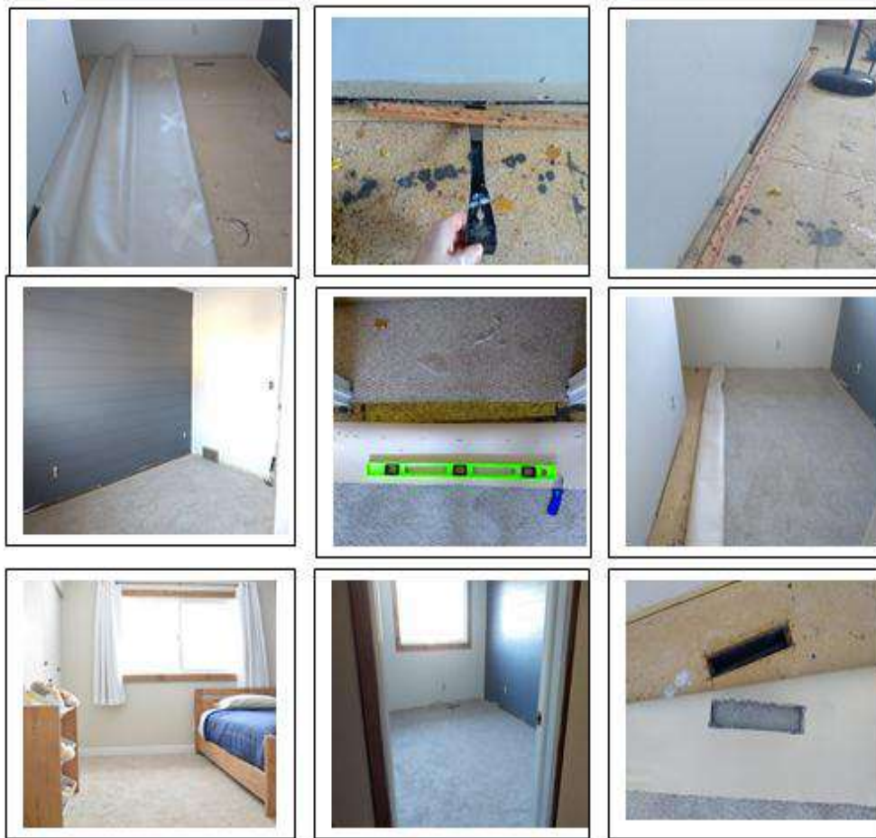
الشكل (2-14) تركيب موكيت الأرضيات
