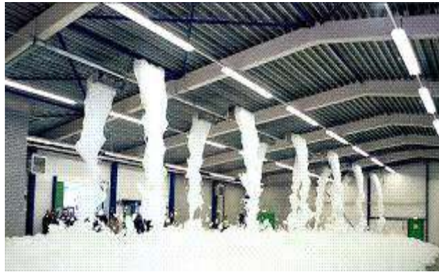
الشكل (2-1) نظام تلقائي بالرغوة
