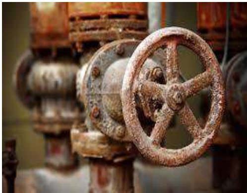
شكل ( 1 - 51 ) تعرض الصمامات إلى التآكل والنضوح والتلف
