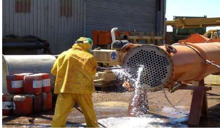
شكل (1 - 63) تنظيف الانابيب لمبادل حراري بالماء
