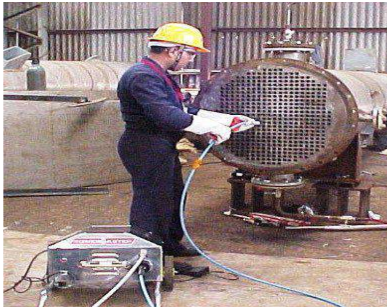
شكل (1 - 61) تنظيف انابيب مبادل حراري
