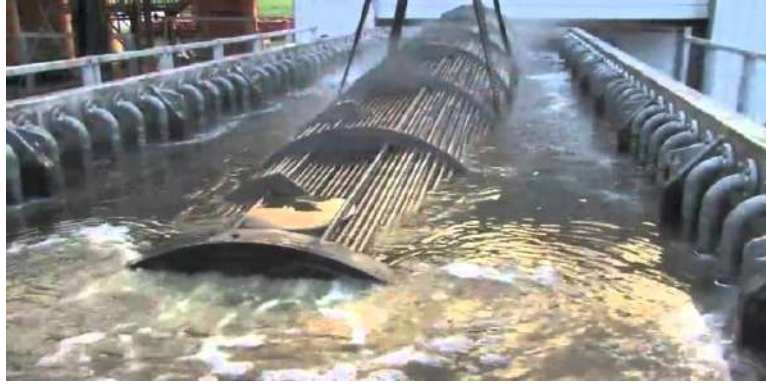
شكل (1 - 60) تنظيف مبادل حراري بالأمواج فوق الصوتية
