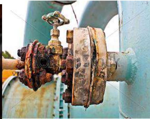
شكل ( 1 - 51 ) تعرض الصمامات إلى التآكل والنضوح والتلف
