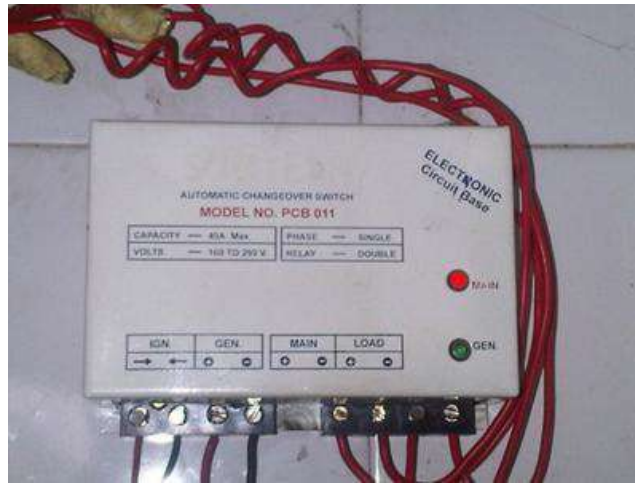
شكل ( 11 - 4 ) يوضح مفتاح تحويل أوتوماتيك
