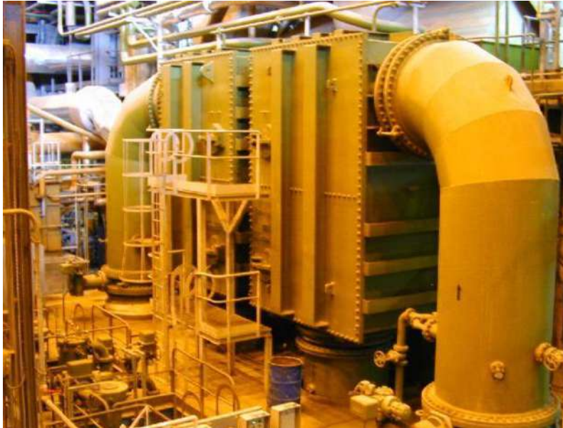
الشكل (22) يوضح صورة لمكثف في محطة حرارية ( للأطلاع فقط )
