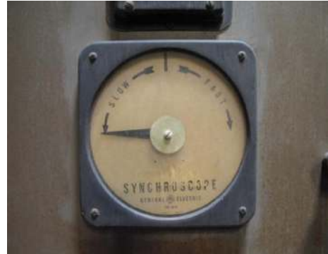
الشكل (38-B) يبين منظار التزامن (Synchro scope أو Synchronizer) يستعمل في عملية التوافق (للاطلاع فقط )
