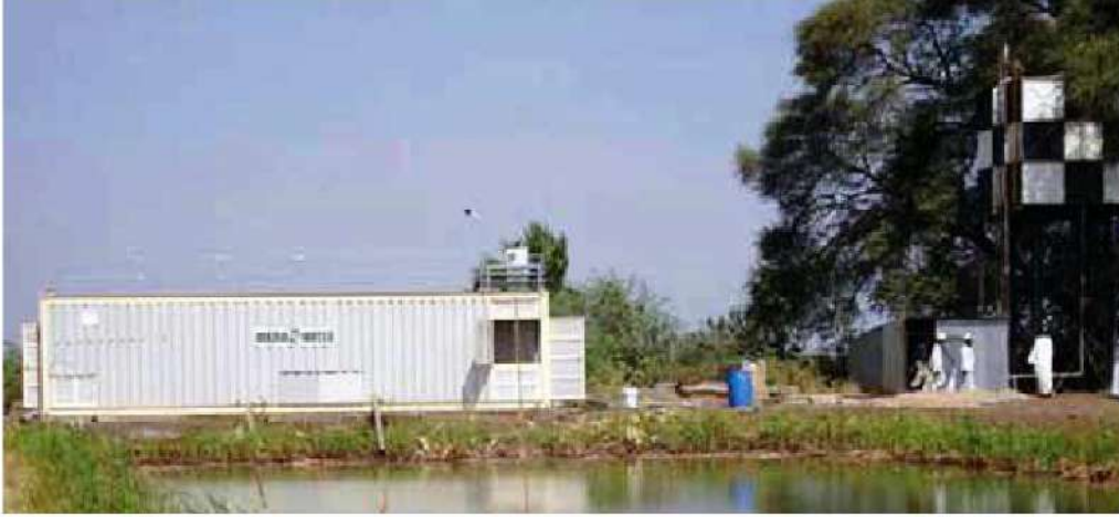
الشكل 8-3 : محطة تصفية مدمجة.
