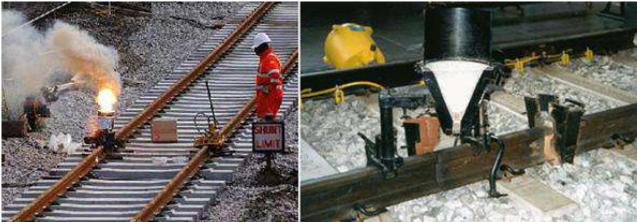
شكل 5-1 مخطط لعملية لحام الترميت
