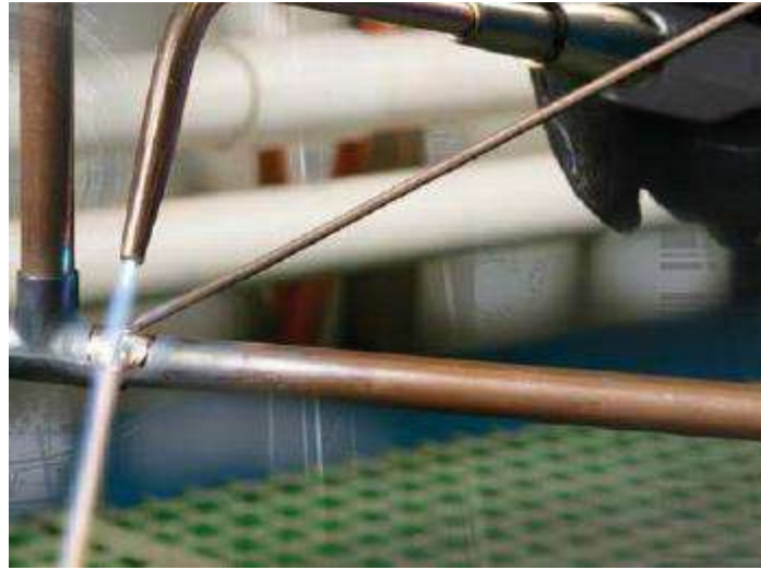
شكل 12-1 ربط أنبوبين من النحاس باستعمال لحام المونة بالمشعل
