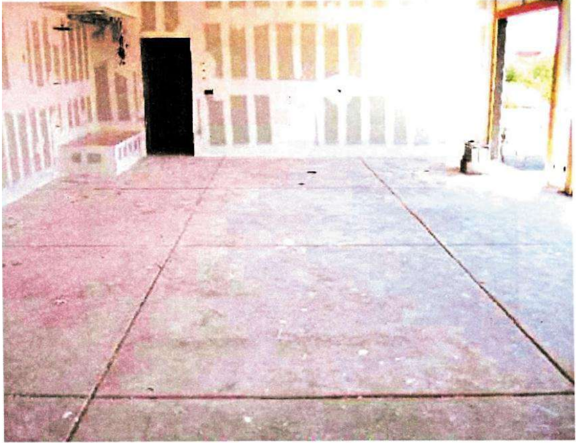
شكل (1-8) إنهاء الأرضيات بالخرسانة
