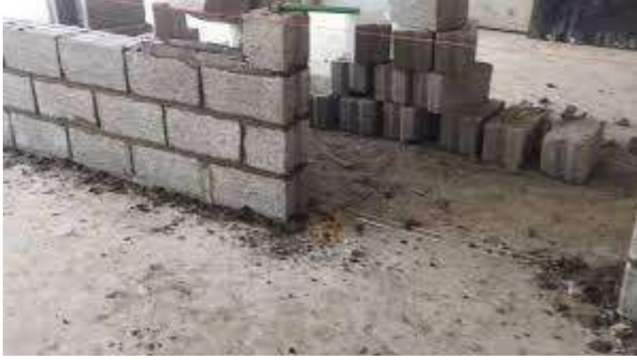
شكل (2-2) الكتلة الخرسانية المستعملة في الجدران
