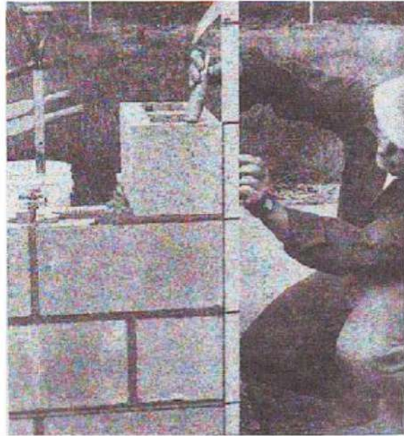
شكل (2-3) الكتلة الخرسانية المستعملة في أركان الجدران
