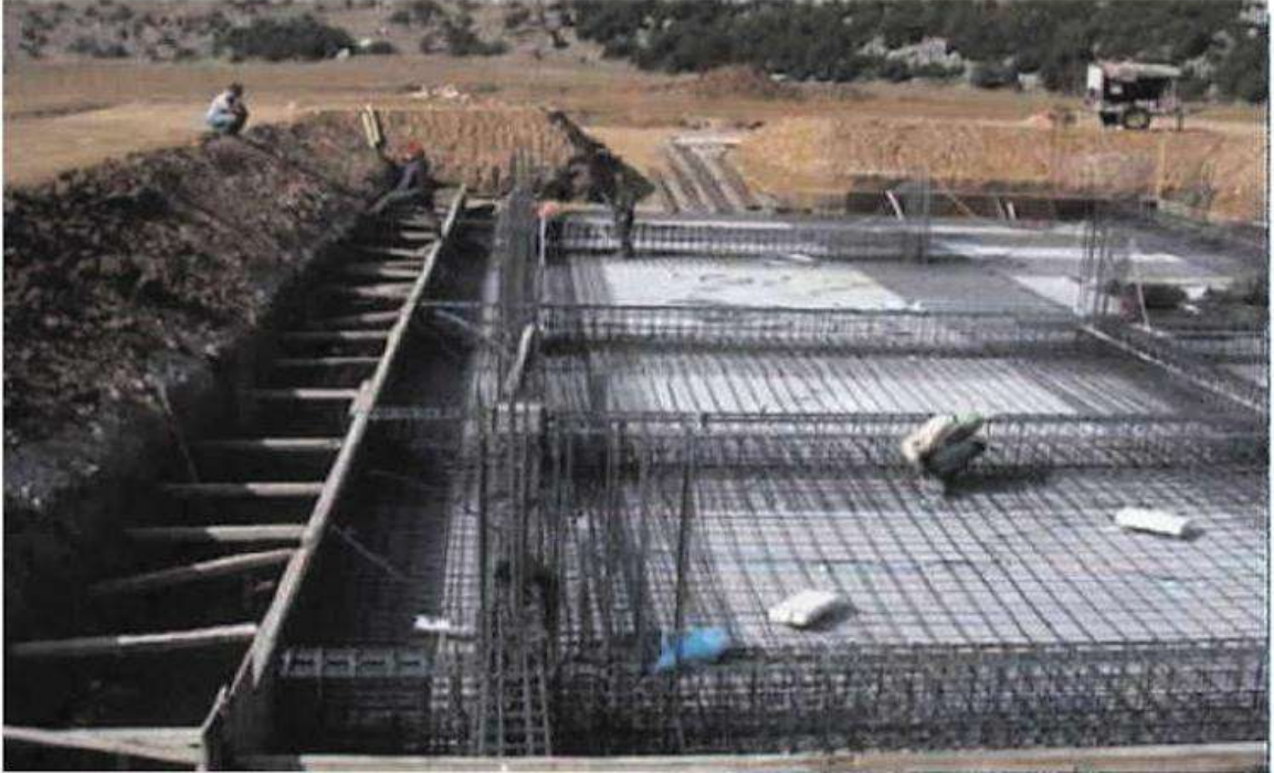
الشكل رقم (4-21) يبين توزيع حديد التسليح وطريقة الربط
