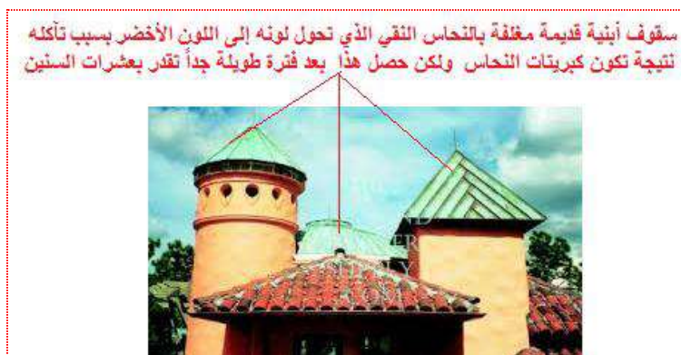
شكل 3-11 صورة أبنية قديمة توضح تحول النحاس إلى كبريتات النحاس
