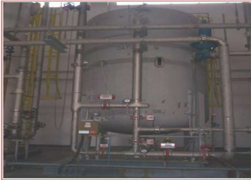
الشكل 10-6 صورة لمبادل كاتيوني في محطة حرارية
