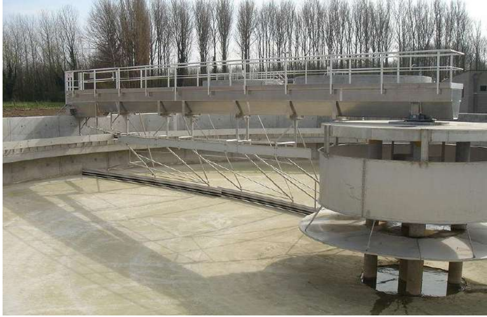
شكل ( 5 - 6 ) حوض الترسيب المستخدم في عملية التثثير الكيميائي
