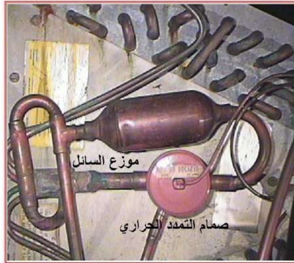
شكل 5-10 صمام تمدد حراري ذو مبادل خارجي مع موزع للوسائل
