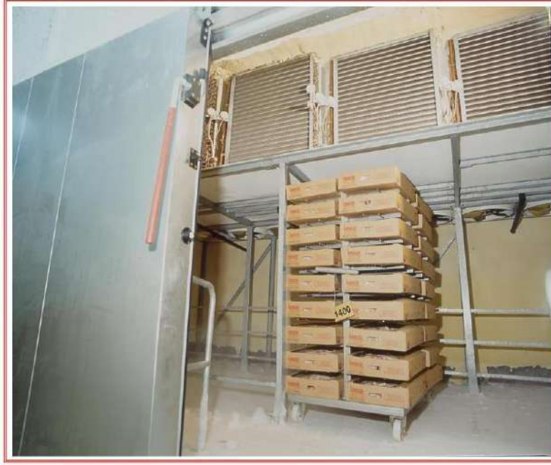
شكل 4-7 التجميد بغرف الهواء الصاعق
