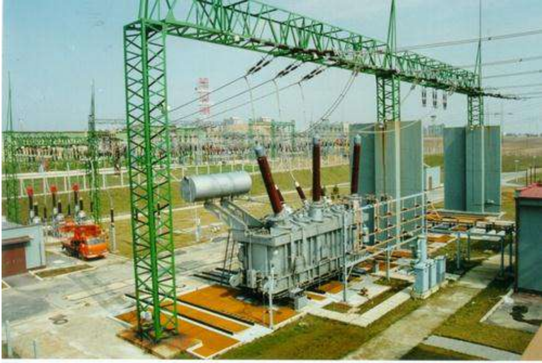
الشكل (4-6) يوضح المحطات الثانوية الخارجية
