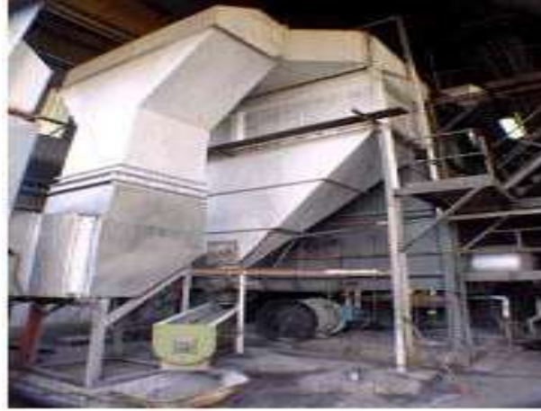
الشكل (19-1) يوضح وحدة تجميع الاتربة والرماد
