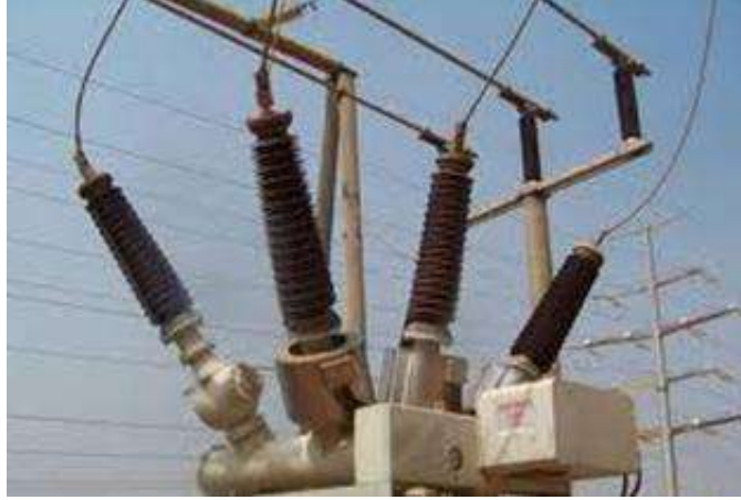
الشكل (7-6) محولة التيار
