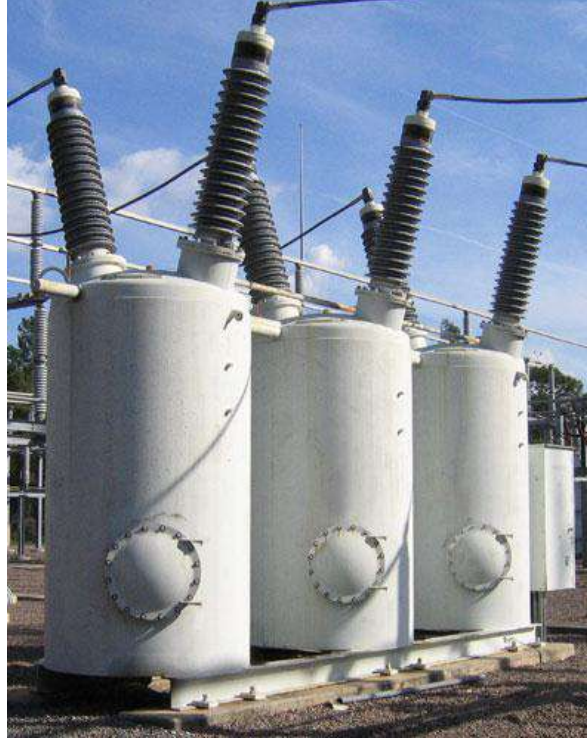
الشكل (11-6) يوضح القاطع الآلي الزيتي
