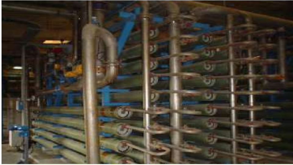
الشكل (17-1) يوضح شبكة تحلية الماء (RO - Reverse Osmosis)
