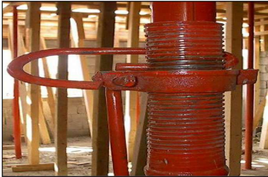
الشكل رقم (٨-١١) عملية إسناد السقف باستخدام (jack)
