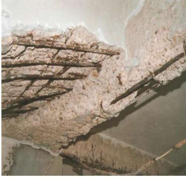
الشكل رقم (٧-١١) تأثير الرطوبة على صبة السقف
