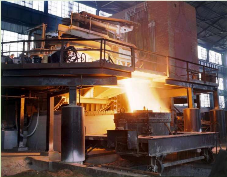
شكل (٢-١) فرن كهربائي لصهر مخلفات الحديد
