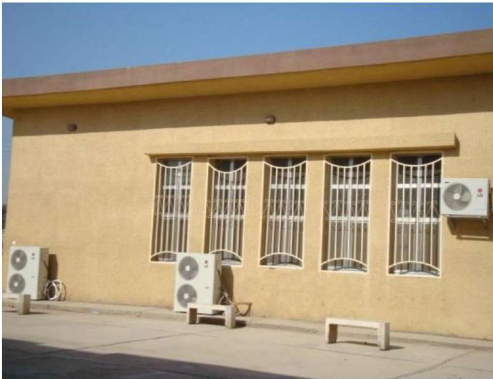
الشكل رقم (٩-٥) عملية توزيع ونصب أجهزة التكييف
