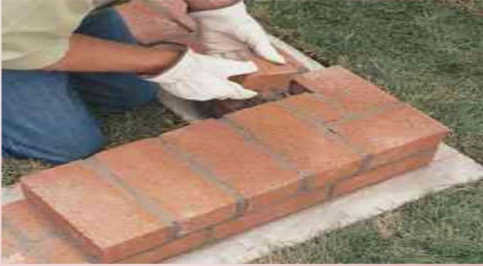
شكل (٤ - ١) بناء الجدار فوق الأساس الجداري
