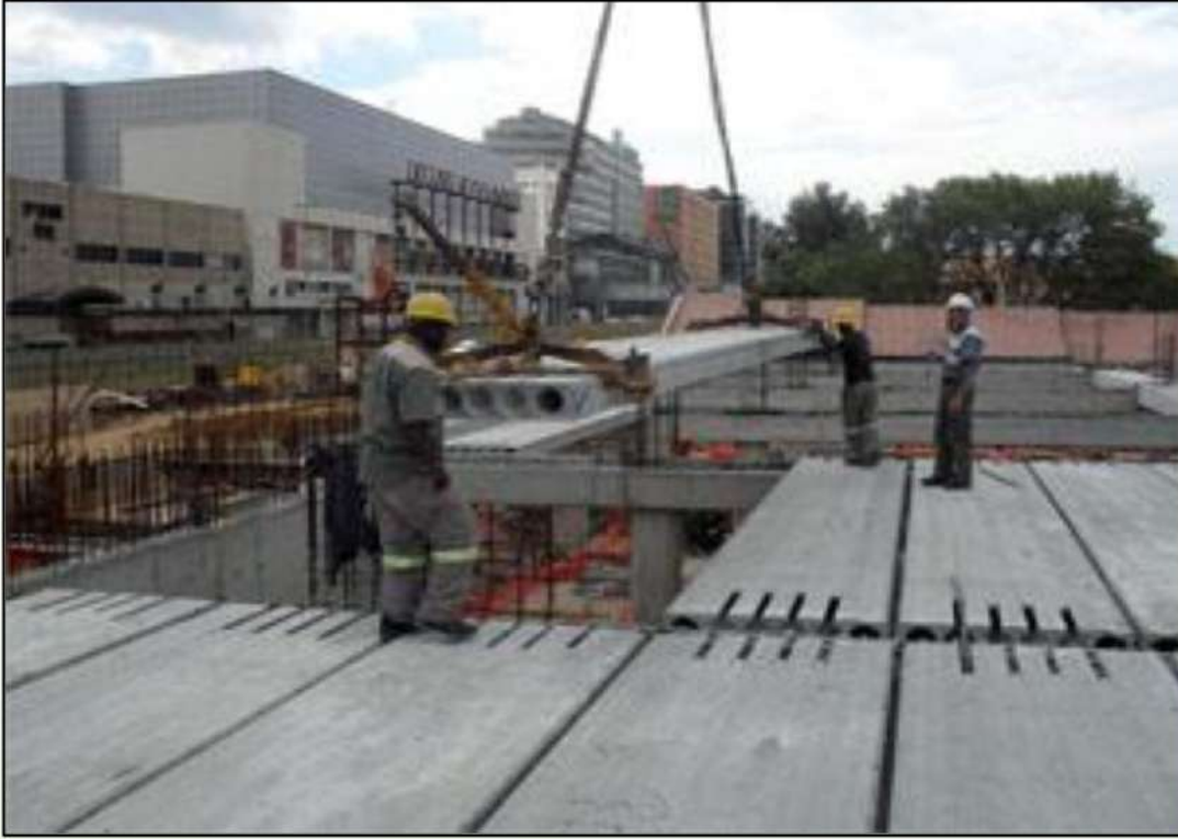
الشكل (١٧-٥) تركيب سقف جاهز
