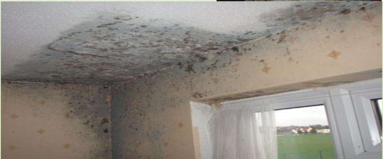
الشكل رقم (١١-١) الرطوبة التي تؤدي إلى تلف البياض
