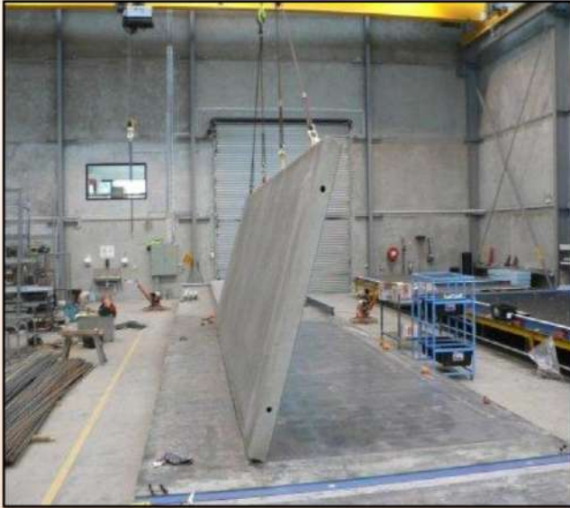
الشكل (٥-٢) يوضح صب الخرسانة في القالب الشكل (٥-٣) طريقة رفع القطع الخرسانية الجاهزة
