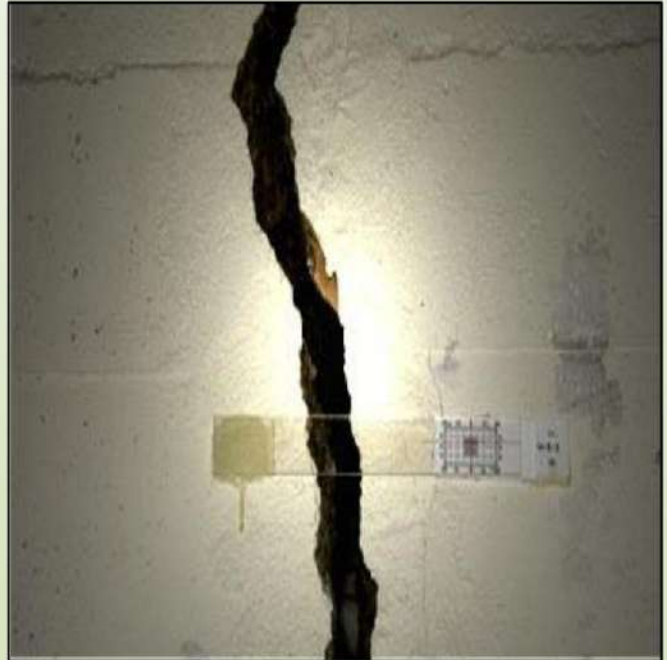
الشكل رقم (١١-٦) يبين الشق العمودي في الجدار وطريقة المعالجة
