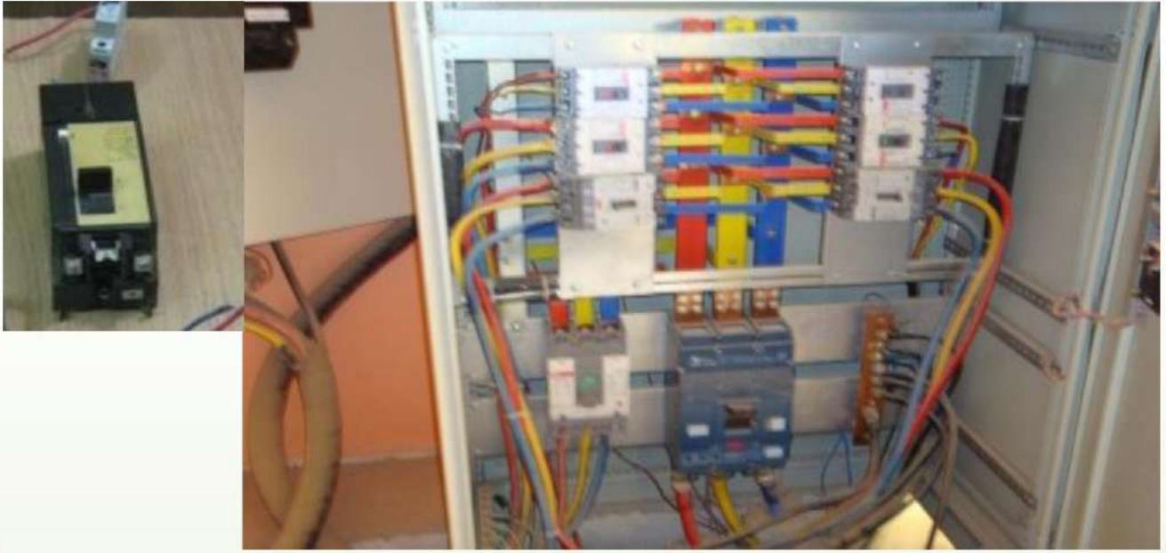
الشكل رقم (٥-٨) اللوحة الرئيسية لتوزيع قواطع الكهرباء
