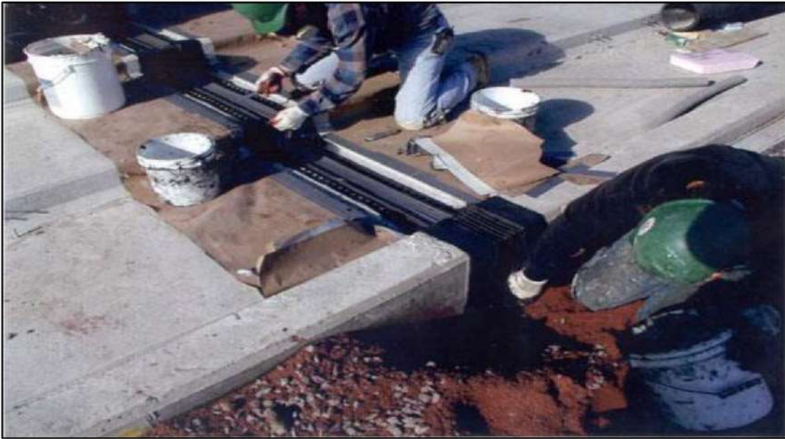
الشكل رقم (١١-١١) معالجة مفاصل التمدد
