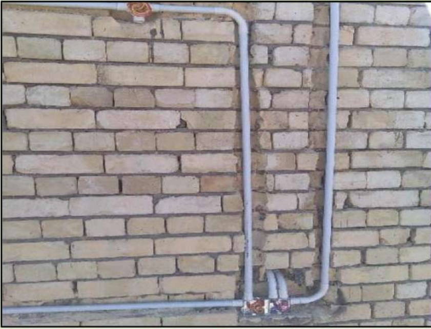
الشكل رقم (٨-٣) التأسيس بالأنابيب
