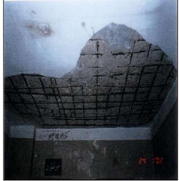
الشكل رقم (٧-١١) تأثير الرطوبة على صبة السقف
