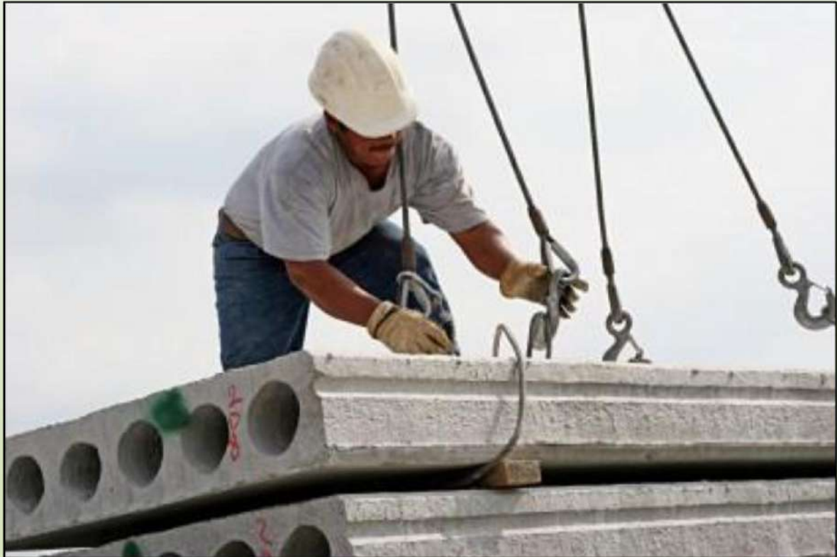
الشكل (٥ - ٩) يوضح سقف خرساني جاهز خلوي
