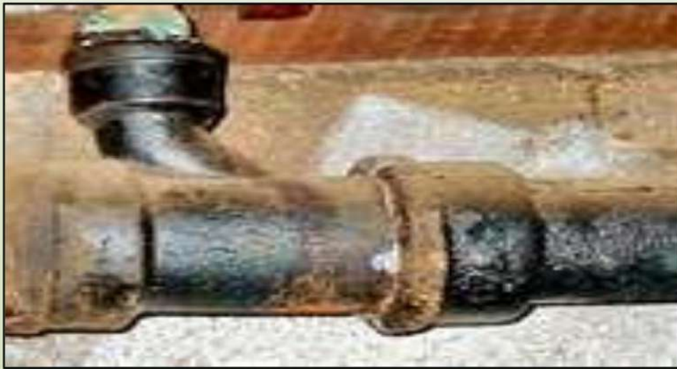
الشكل رقم (١١-٥) يبين تلف أنابيب الصرف الصحي
