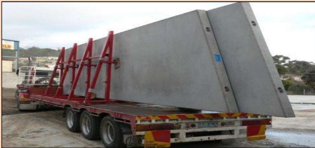
الشكل (٥-٤) يوضح نقل القطع الخرسانية الجاهزة
