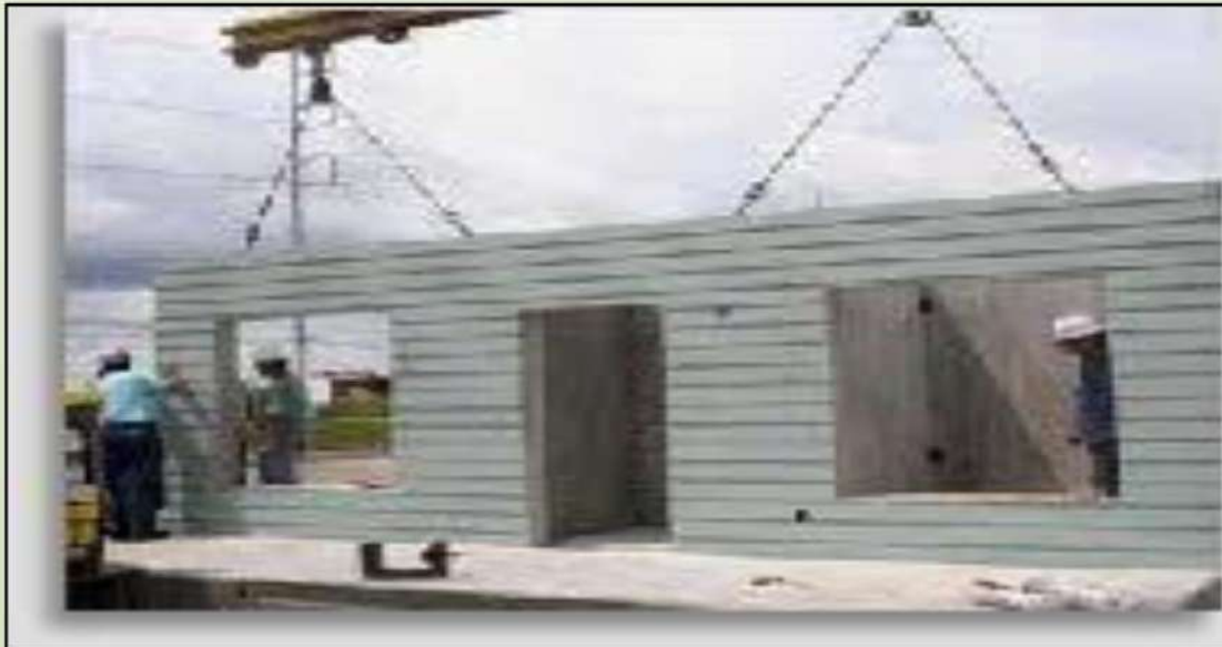
الشكل رقم (٥-١٦) تركيب جدار جاهز
