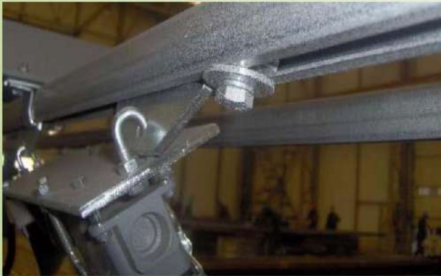
الشكل رقم (١-٥) يوضح عملية ربط الحديد بالبراغي
