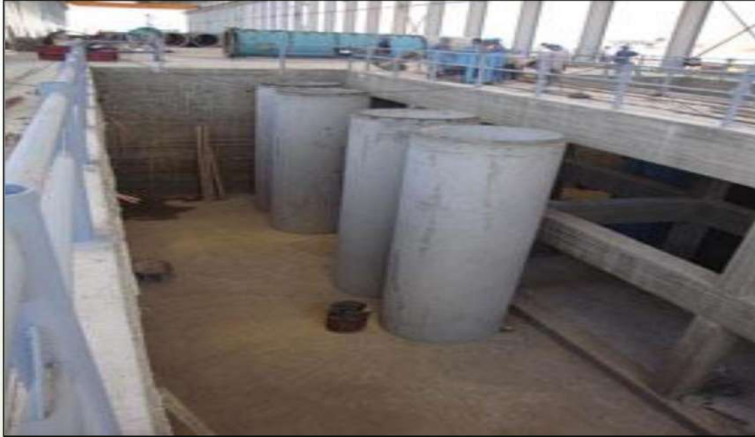
الشكل (١١ - ٥) يوضح قطع لركائز مسبقة الصب
