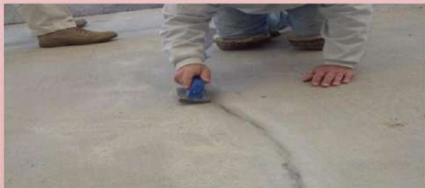
الشكل رقم (١١-٤) مراحل معالجة التشققات في الصبة الخرسانية
