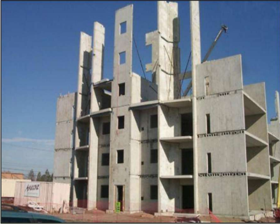
الشكل (٥ - ١٥) يوضح تركيب الابنية الخرسانية الجاهزة والمفاصل المتكونة بين القطع الجاهزة
