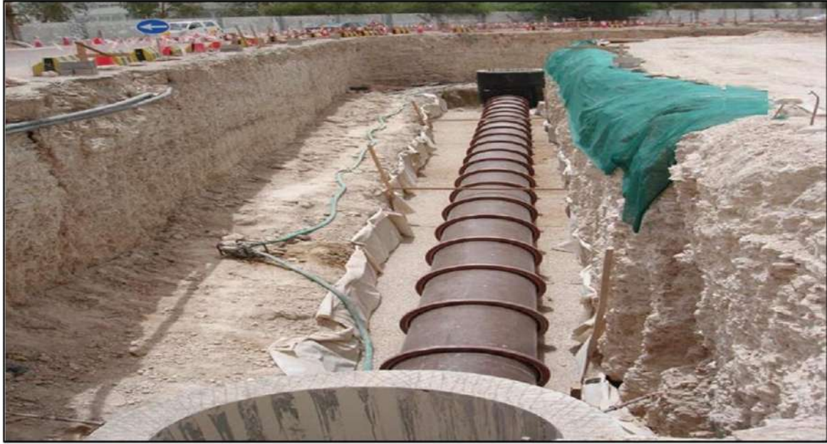
الشكل (3 – 1) مد شبكات الصرف الصحي
