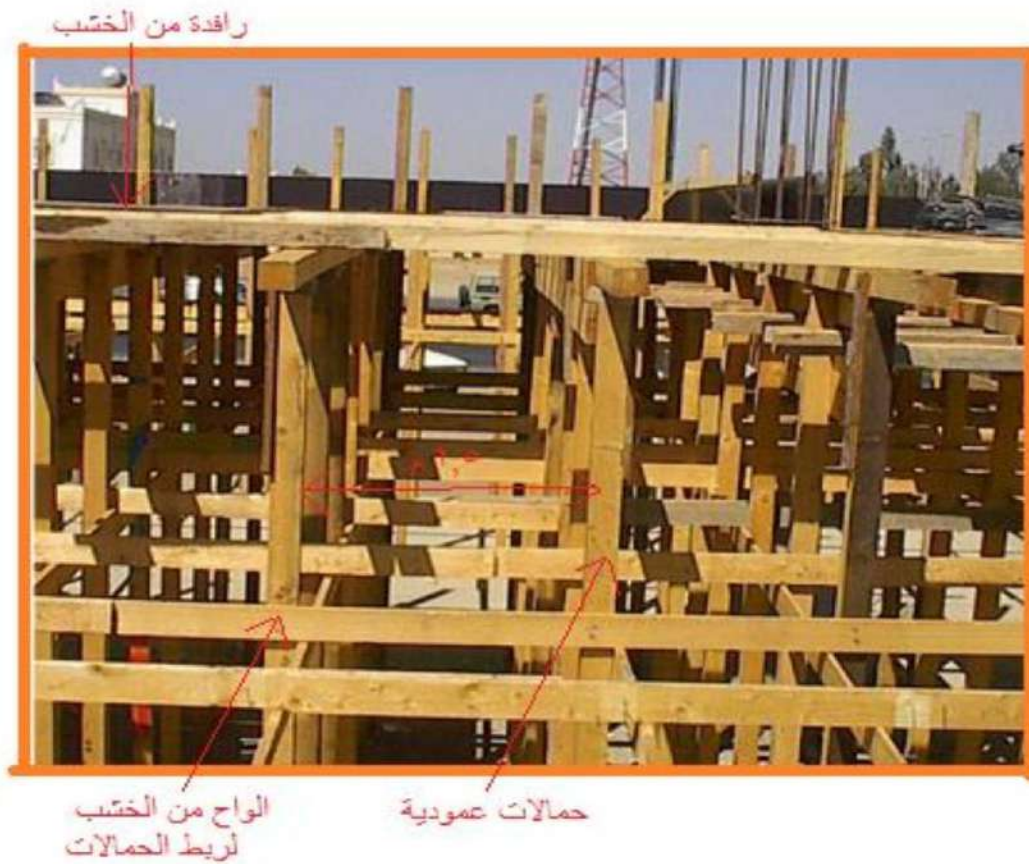
الشكل رقم (2) يبين كيفية نصب القوالب الخشبية
