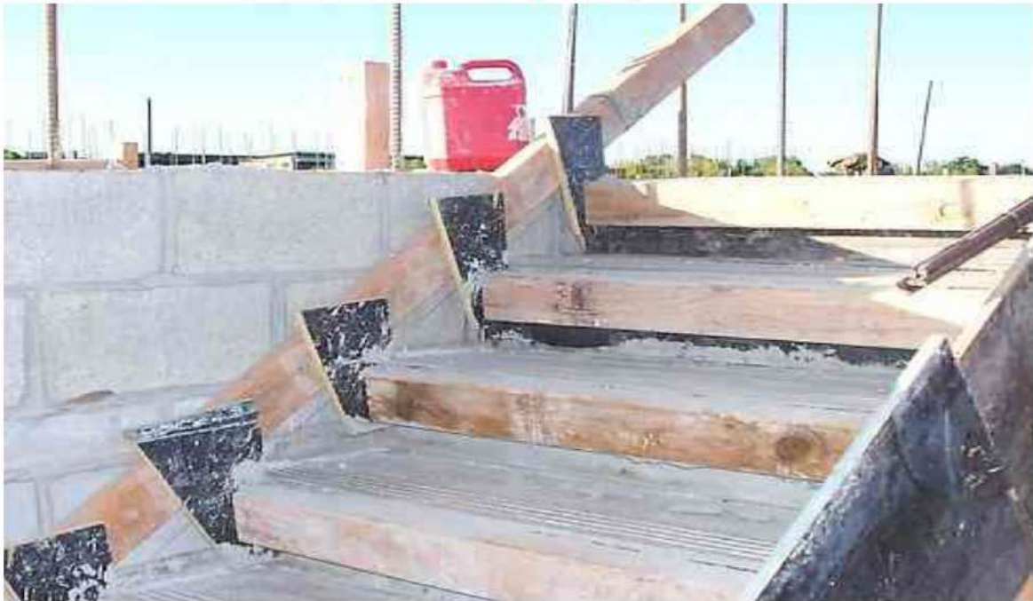
شكل (15) : صب درجات السلم بالخرسانة
