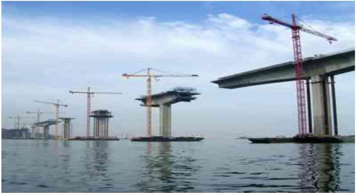
شكل (6) : أسس الدعامات من الخرسانة المسلحة لجسر غير منجز
