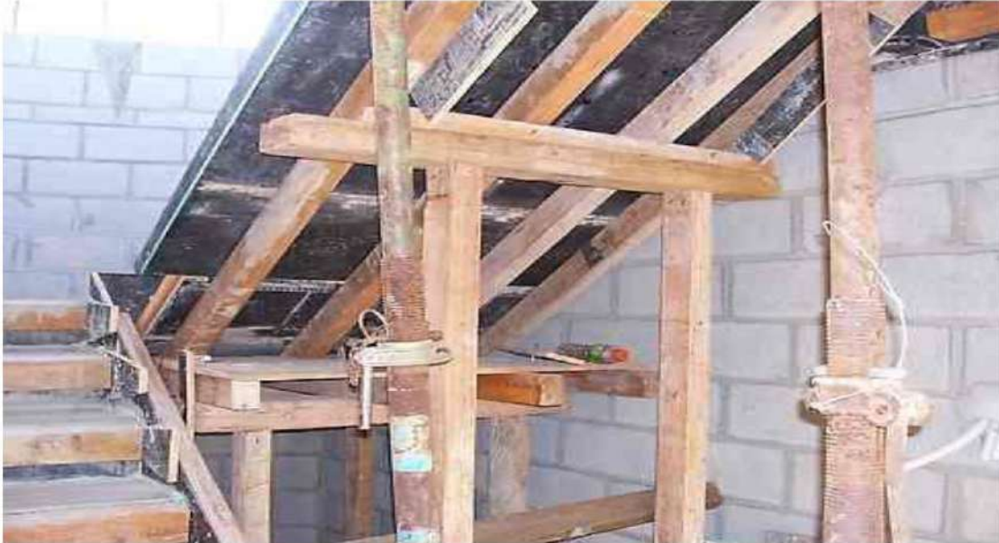
شكل (13) : تثبيت القالب الخشبي للسلم
