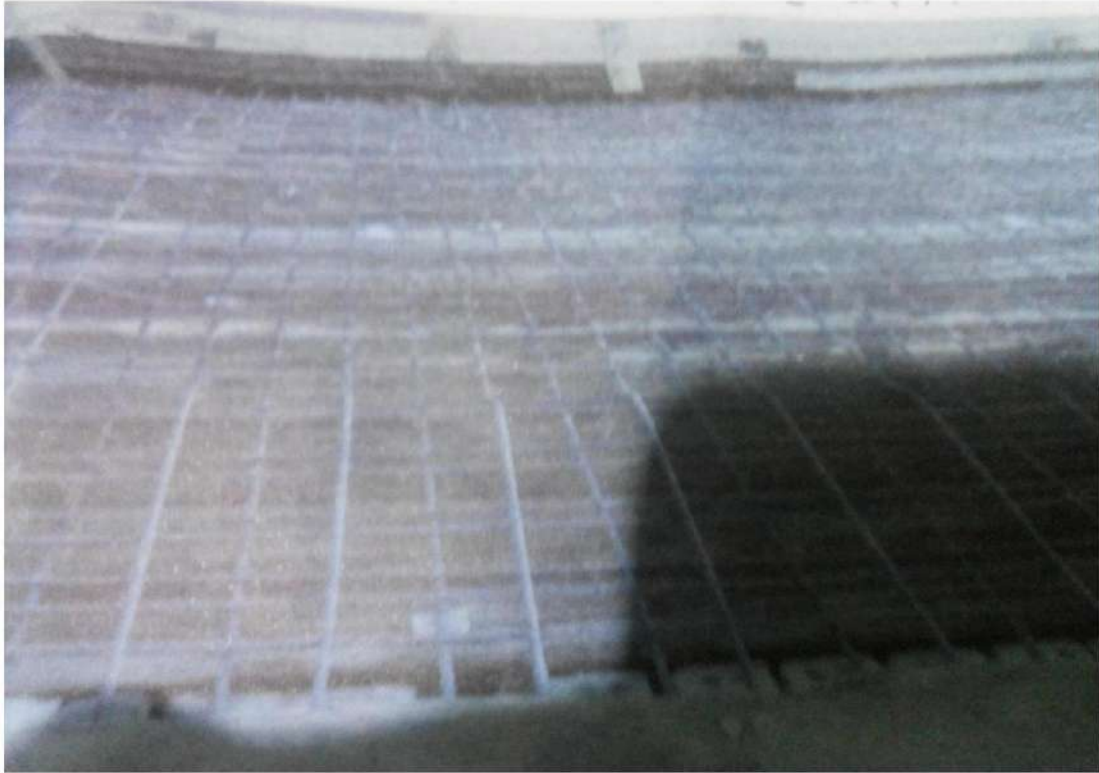
الشكل (4) يوضح طريقة فرش حديد التسليح على السقوف
