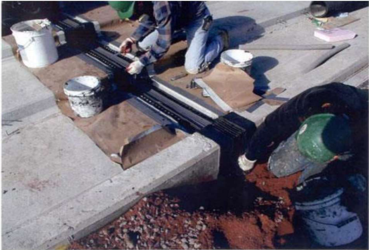
الشكل (4-14) عملية معالجة المفاصل الإنشائية بين قطع الكونكريت
