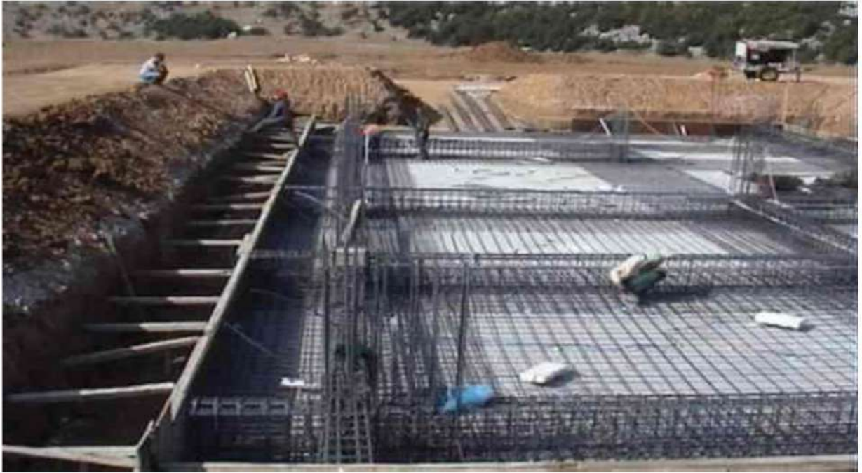
شكل (4) حديد التسليح لأساس حصيري
