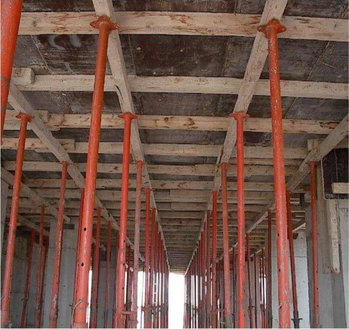
الشكل رقم ( 6 ) قالب خشب لسقف خرساني
