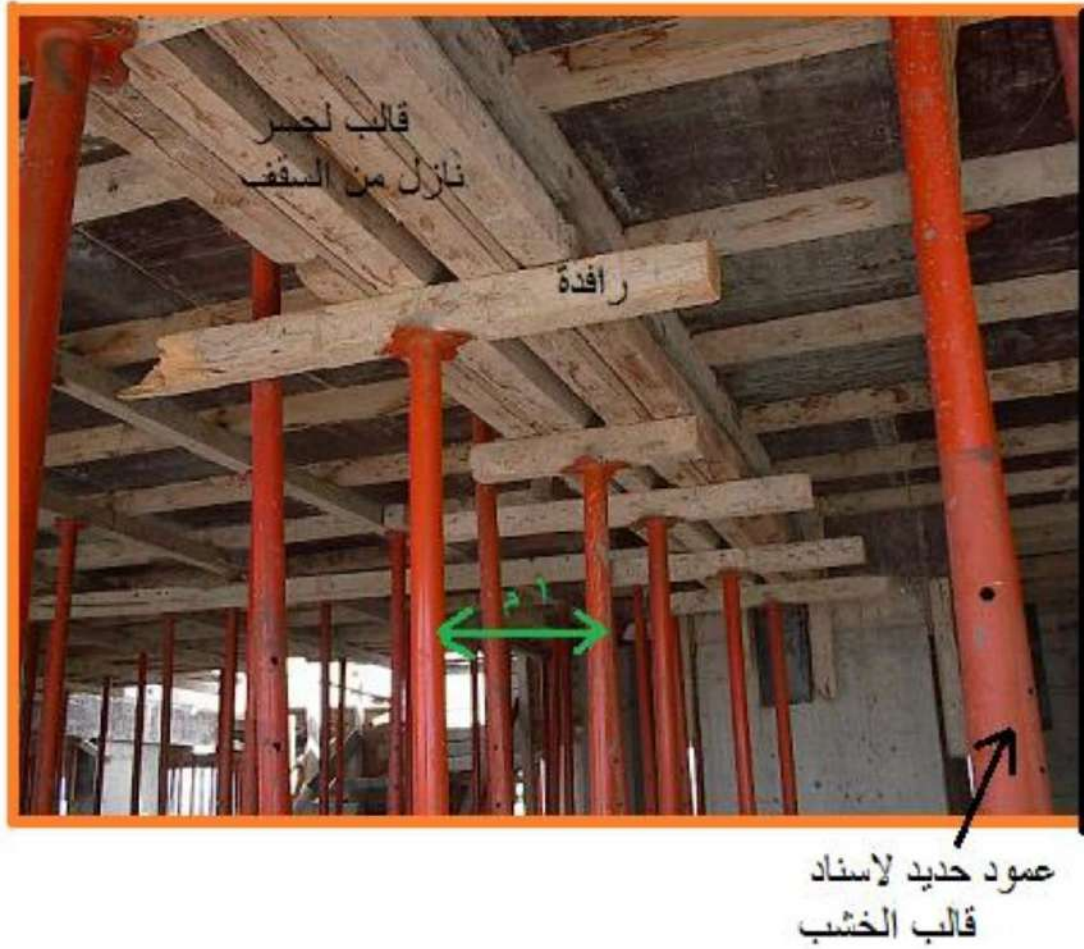
الشكل رقم ( 5 ) قالب الروافد والسقوف الخرسانية
