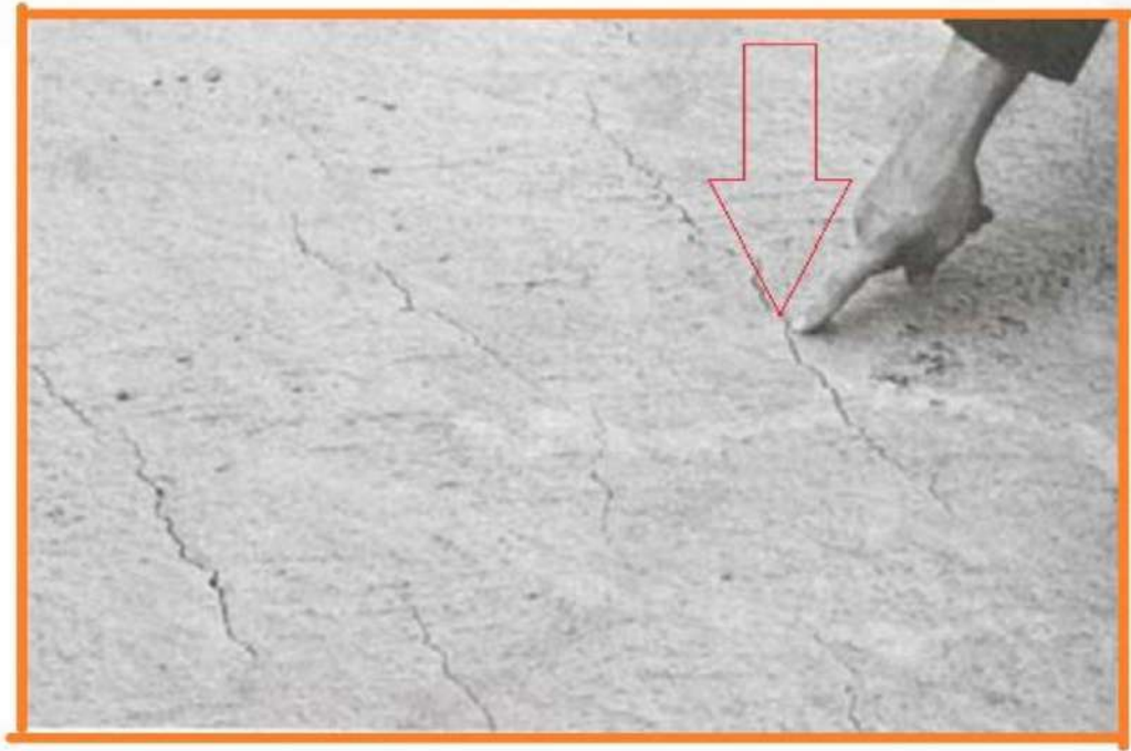
الشكل ( 3 ) التشققات في الصب
