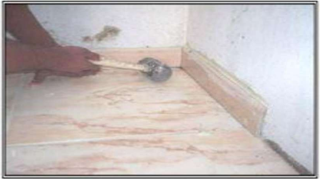
الشكل (13) الصور تبين مراحل العمل لتثبيت الازارة
