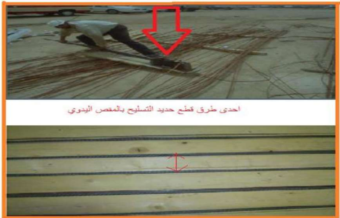
الشكل ( 1 ) حديد التسليح وطريقة القطع بالمقص اليدوي
