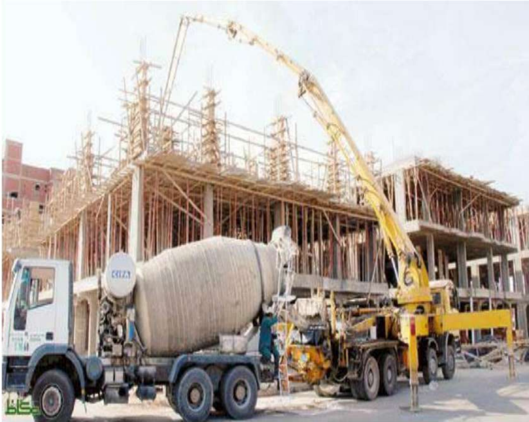
الخباطة المركزية الميكانيكية للخرسانة
