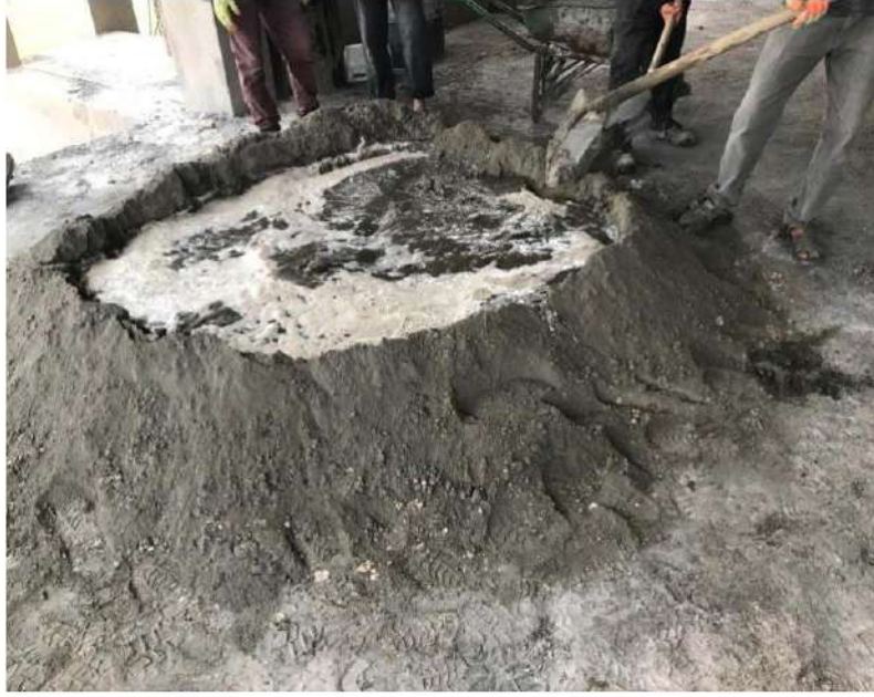
الشكل ( 5 ) عملية إضافة الماء إلى الحصى
