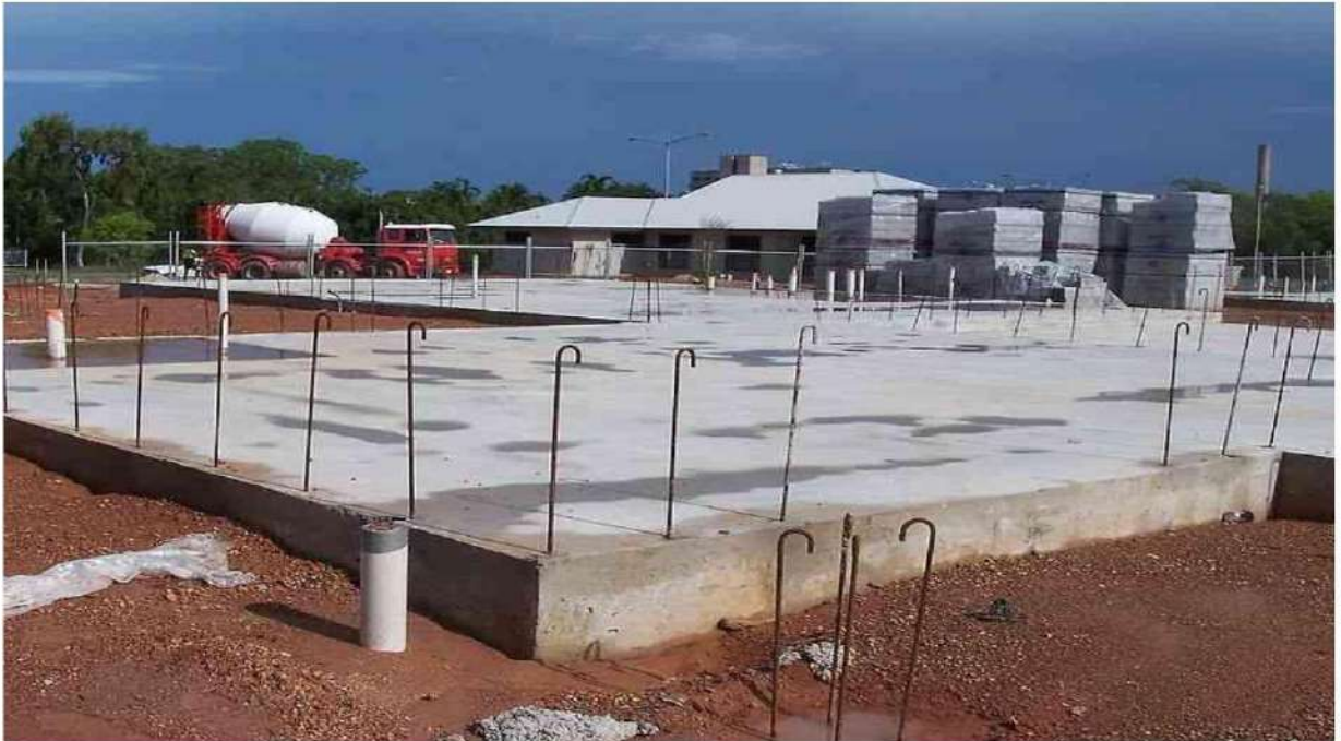
شكل ( 5 ) أساس حصيري من الخرسانة المسلحة
