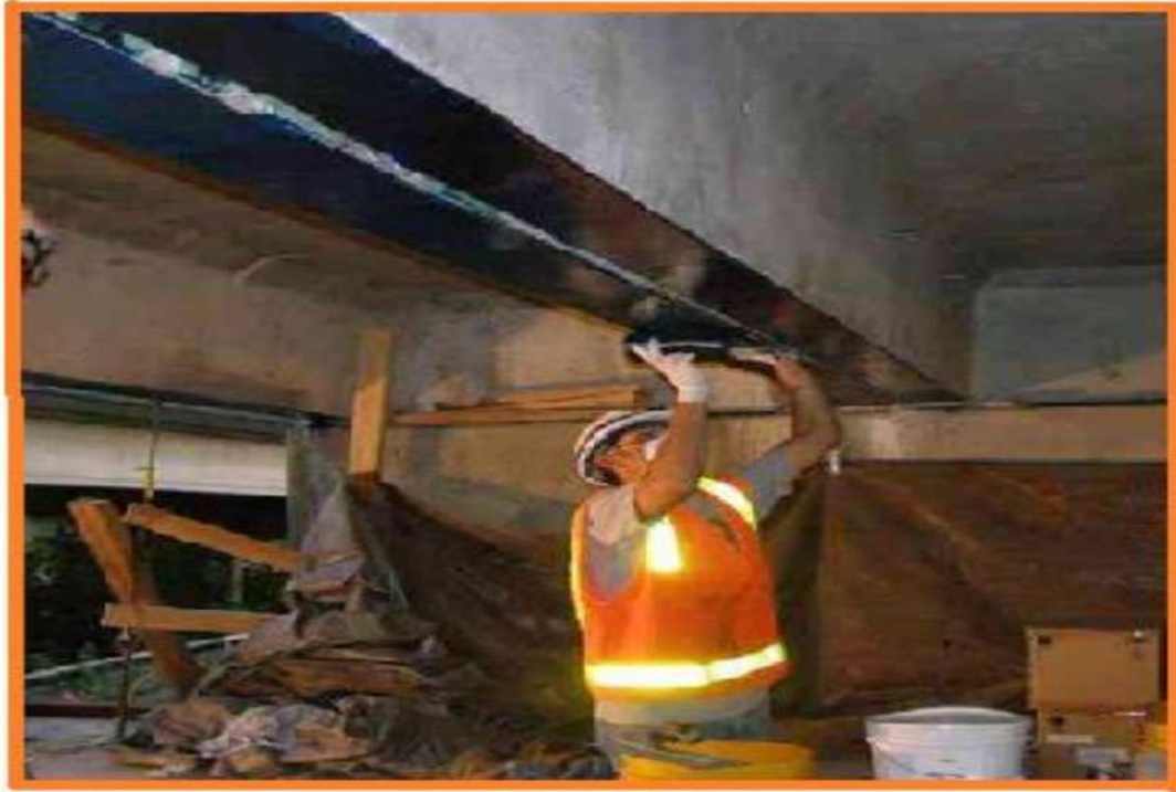
شكل ( 7 ) : استخدام ألياف الكربون على شكل طبقات لإعادة تأهيل الجسور
