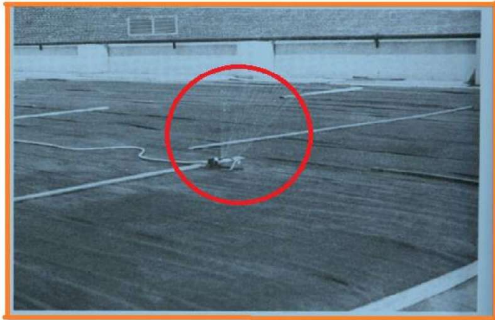
الشكل ( 13 ) إحدى طرق رش الخرسانة
