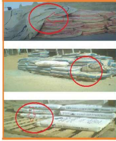
الشكل ( 2 - أ ) الصور تبين طريقة خزن المواد بشكل صحيح
