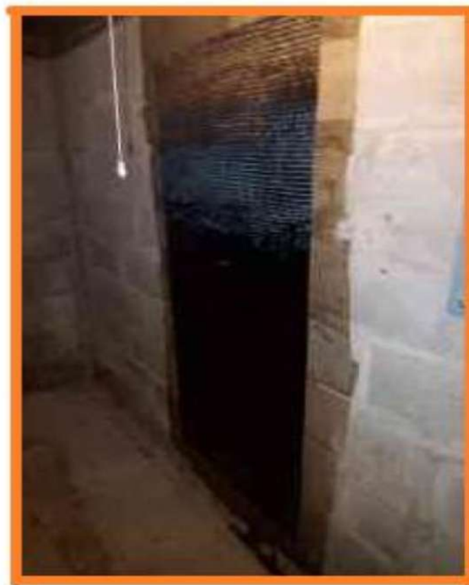
شكل ( 6 ) : استخدام ألياف الكربون على شكل طبقات لمعالجة الجدران
