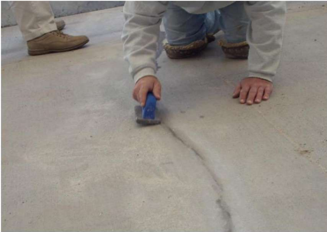
الشكل (4) معالجة التشققات في الصبة الخرسانية
