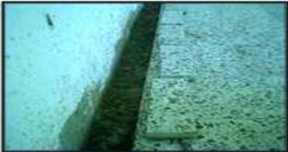
د - عملية إنهاء الحافات المجاورة إلى الجدار
