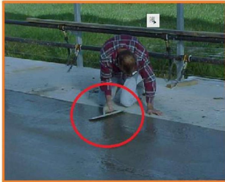
الشكل (11) عمليات إنهاء الصب
