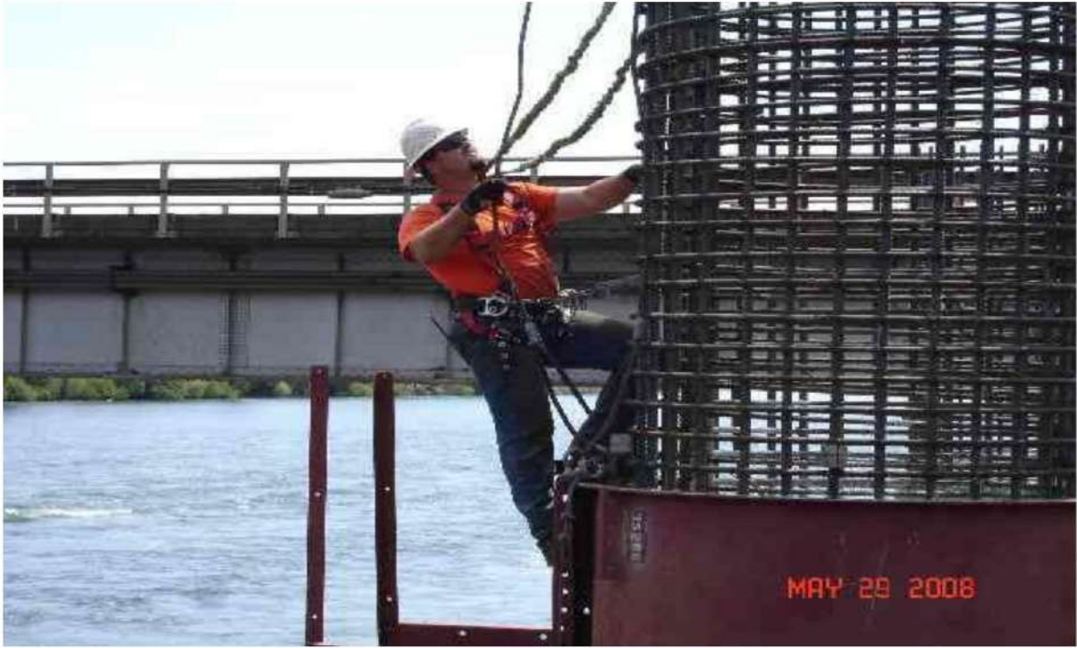
شكل (9) : إنزال حديد تسليح الركيزة
