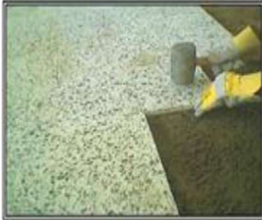
ج - عملية الاستمرار في أكساء الأرضية
