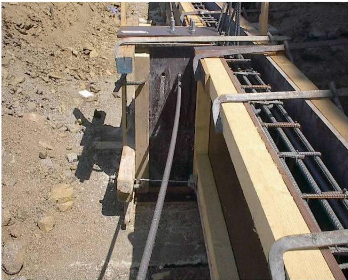
الشكل رقم ( 7 ) قالب خشبي لصب جدار مسلح
