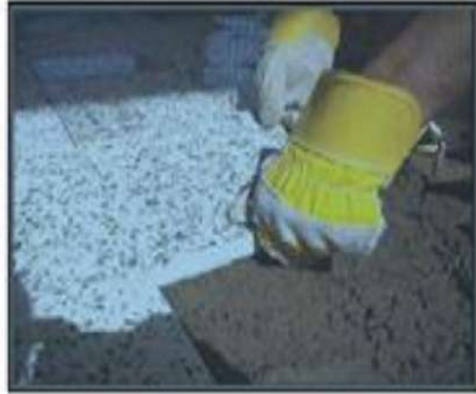
ج - عملية الاستمرار في أكساء الأرضية
