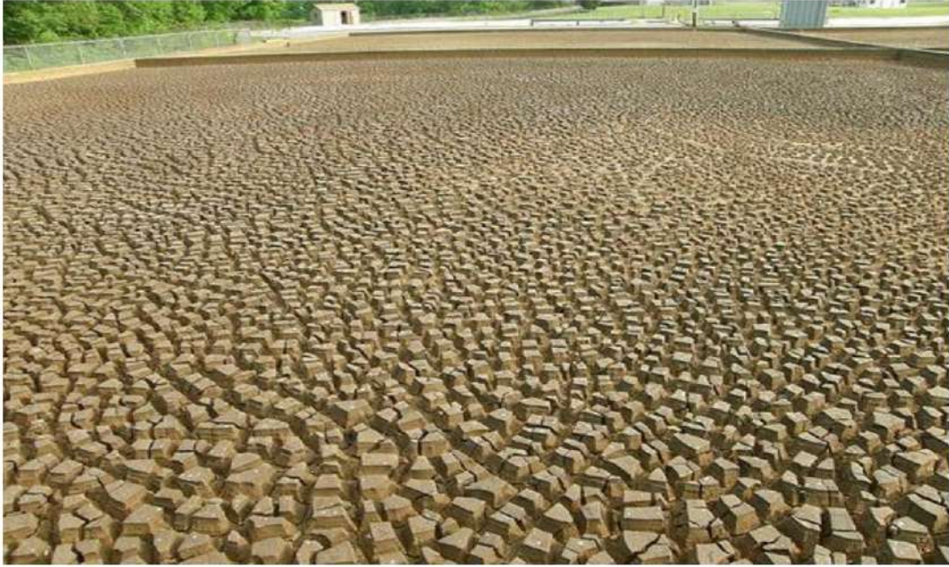
الشكل ( 2.22 ) : أسطح الرمل المستخدمة في تجفيف الحمأة
