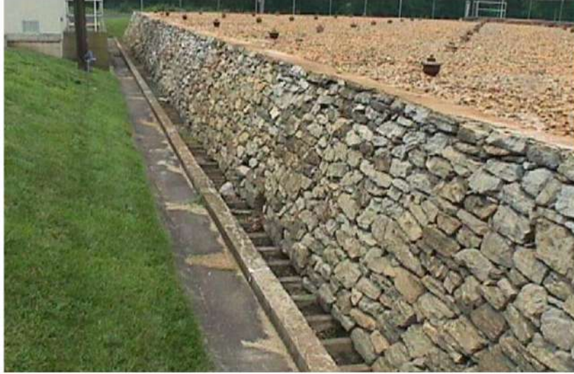
شكل (17-8) منظر جانبي لمنظومة التجميع للمرشح الحيوي.
