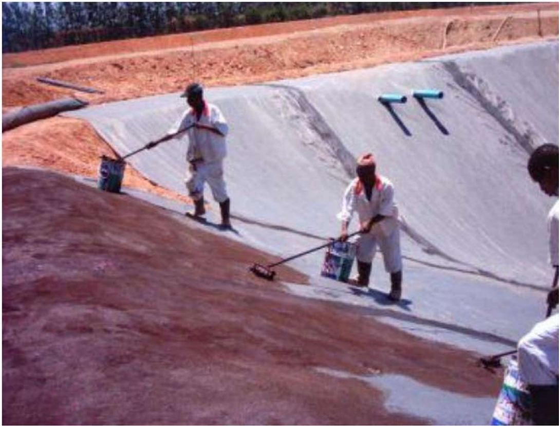
شكل(3.19): مراحل تنفيذ بحيرة أكسدة
