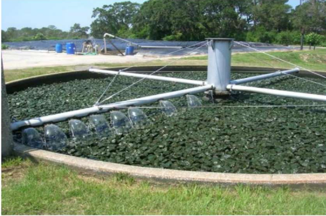
شكل ( 2.17 ) المرشح الحيوي في أثناء العمل
