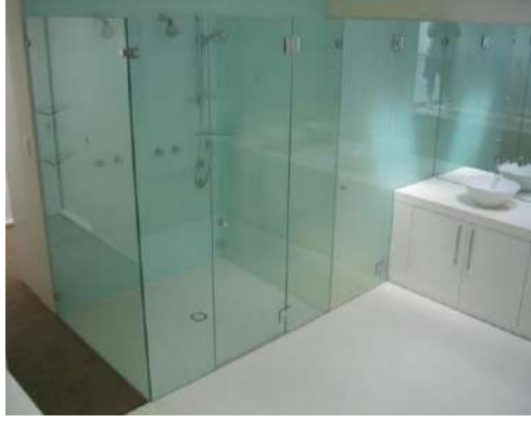
شكل 5-35 استعمالات الزجاج المقسى في الزجاج الخلفي للسيارات وشاورات الحمامات.
