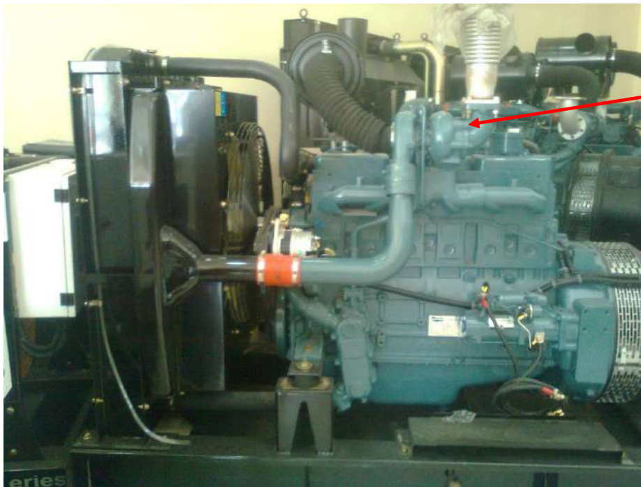
شكل (120-1) منظومة تبريد هواء الدخول الى المحرك
