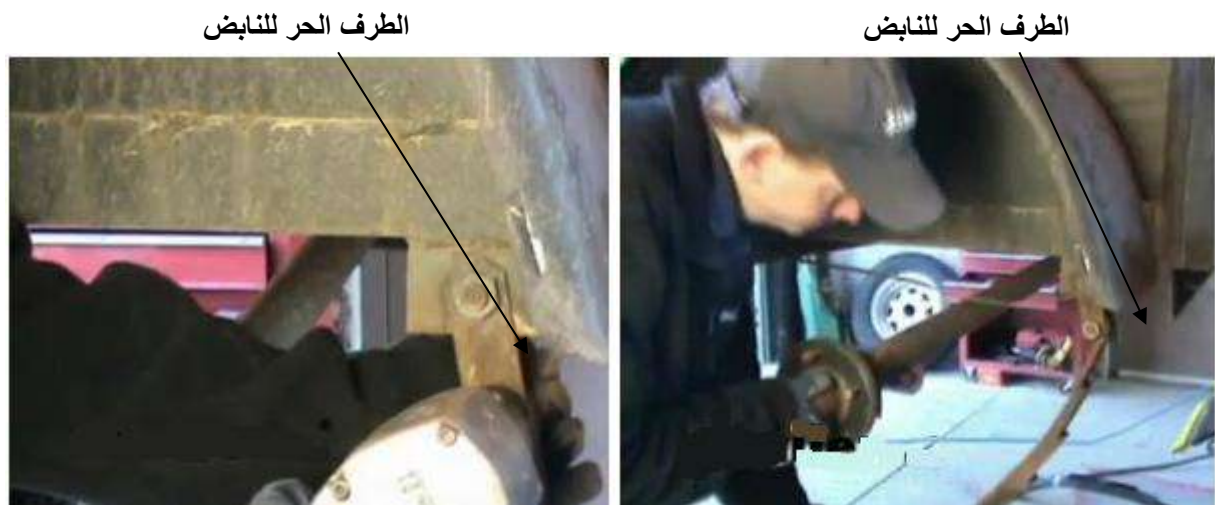
شكل ( 18-3 ) وضع النابض والمحور مع على مسند منخفض شكل ( 19-3 ) فتح صامولة لولب ربط النابض الطرف الحر
