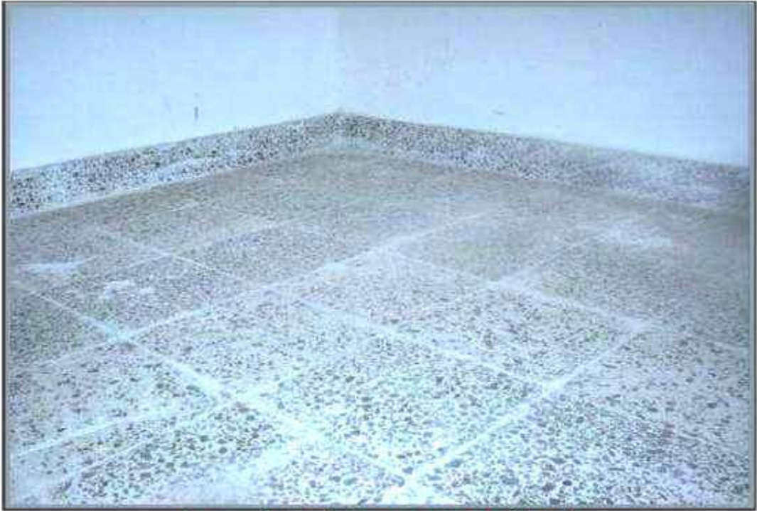
شكل رقم (٢٤) الانتهاء من تبليط الارضية مع الازارة
