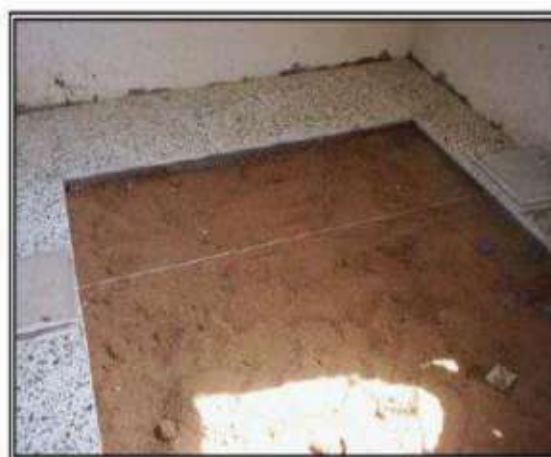
شكل رقم (22) خطوات العمل الاولى لتثبيت الارضية بالكاشي
