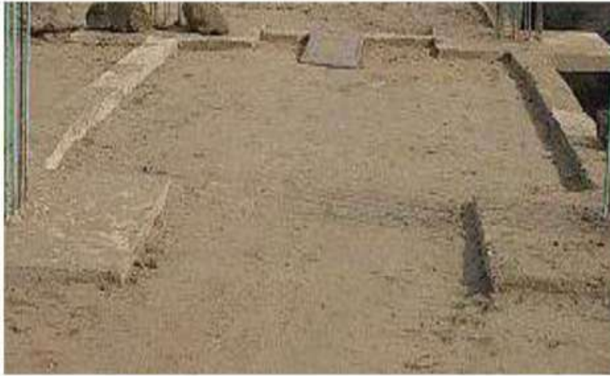
شكل رقم (18) عملية تهيئة الأرض بعد فرش التراب والحدل
