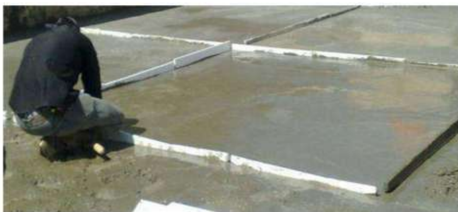
شكل رقم (21) عملية صب الأرضية مع تثبيت مفاصل التمدد
