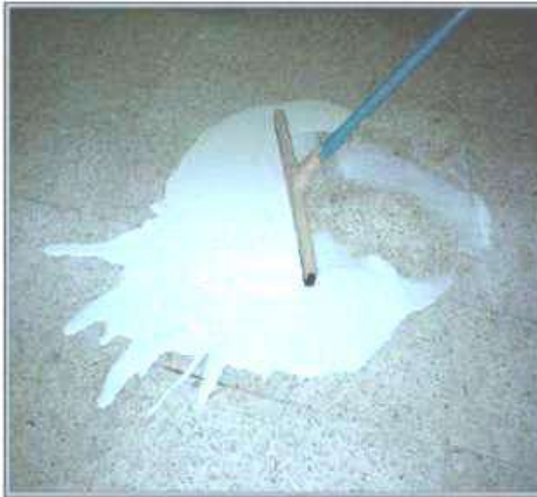
شكل رقم (٢٦) عملية ملأ الفواصل بمونة الشريت
