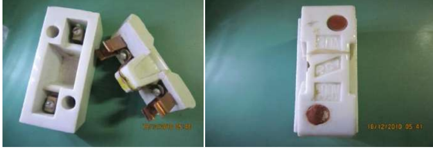
الشكل (6-2) المصهر الذي يمكن أستبدال سلكه لحماية الشبكة الكهربائية للمنزل
