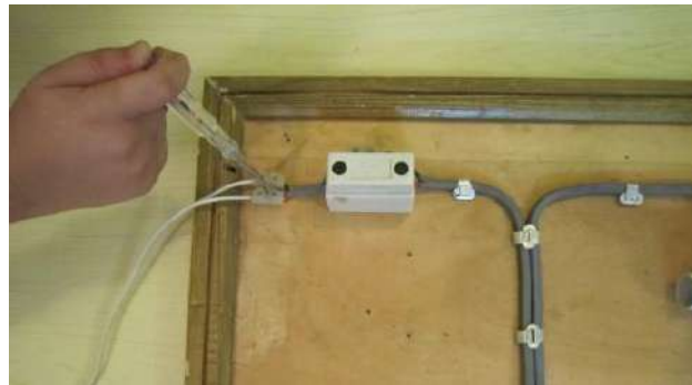
الشكل (6-21) الكشف عن القطب الحار بواسطة درنفييس الفحص
