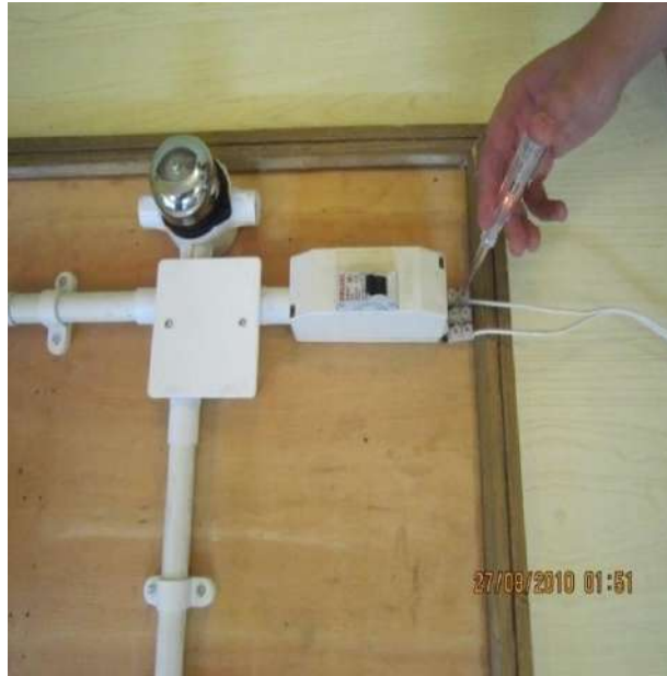
الشكل (6-45) الكشف عن الخط الحار بواسطة درنفييس الفحص
