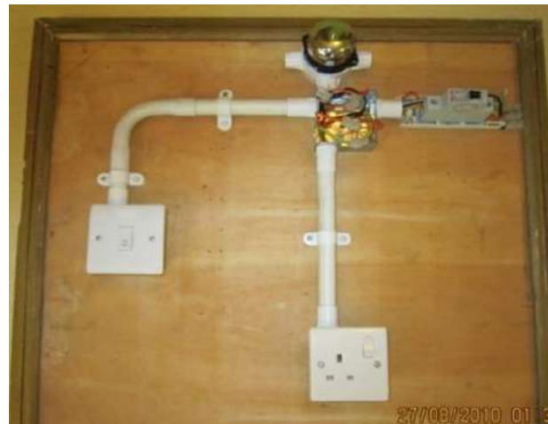
الشكل (6-43) ربط أسلاك دائرة الجرس والمأخذ الى العناصر الكهربائية
