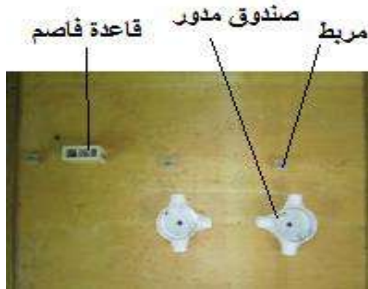
الشكل (2-9) تثبيت الصناديق وقاعدة الفاصم والمربط
