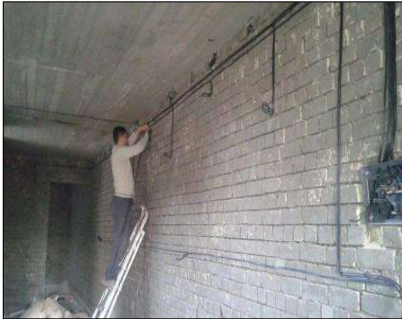
الشكل (6-11) التأسيس الكهربائي تحت البياض
