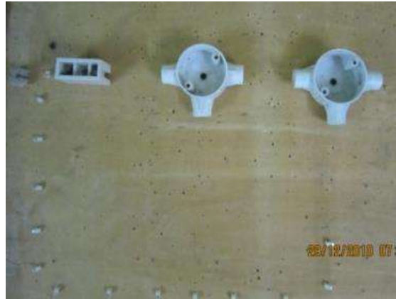
الشكل (2-15) تثبيت صناديق التوزيع وقاعدة المصهر
