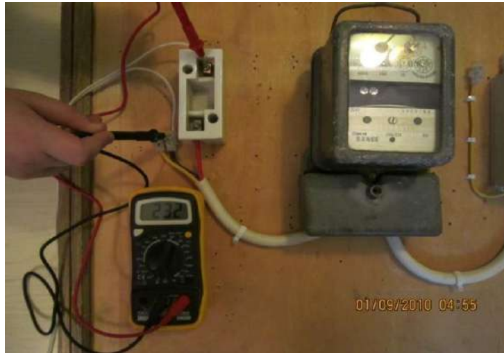
الشكل (6-54) قياس قيمة جهد مصدر التغذية للشبكة الكهربائية الوطنية
