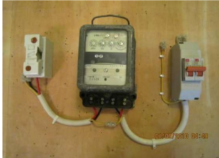
الشكل (6-53) توصيل نهايات الكيبل الرئيسي الى العناصر الكهربائية للوحة القدرة
