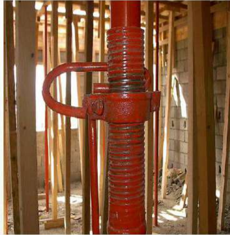
الشكل رقم (2) يوضع جزء من عمود القالب الحديدي الخاص بضبط الارتفاع
