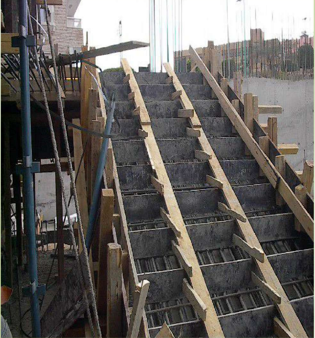
الشكل رقم (5) يوضح القالب الخشبي للسلم وحديد التسليح
