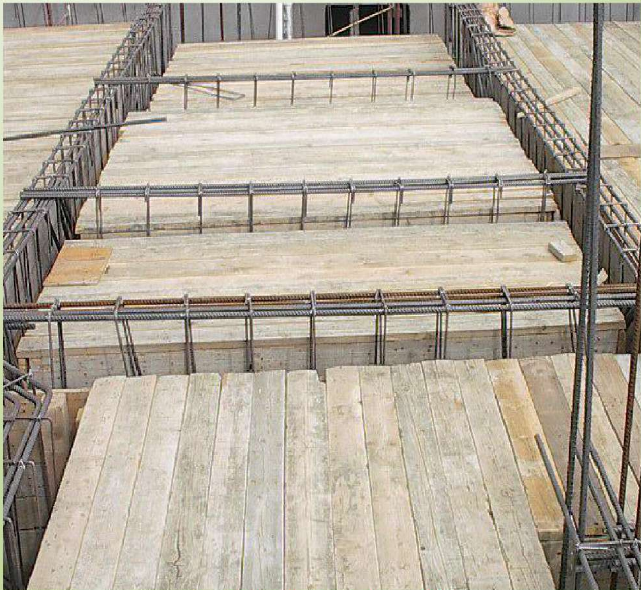
الشكل رقم (4) يوضح قالب السقف والجسور
