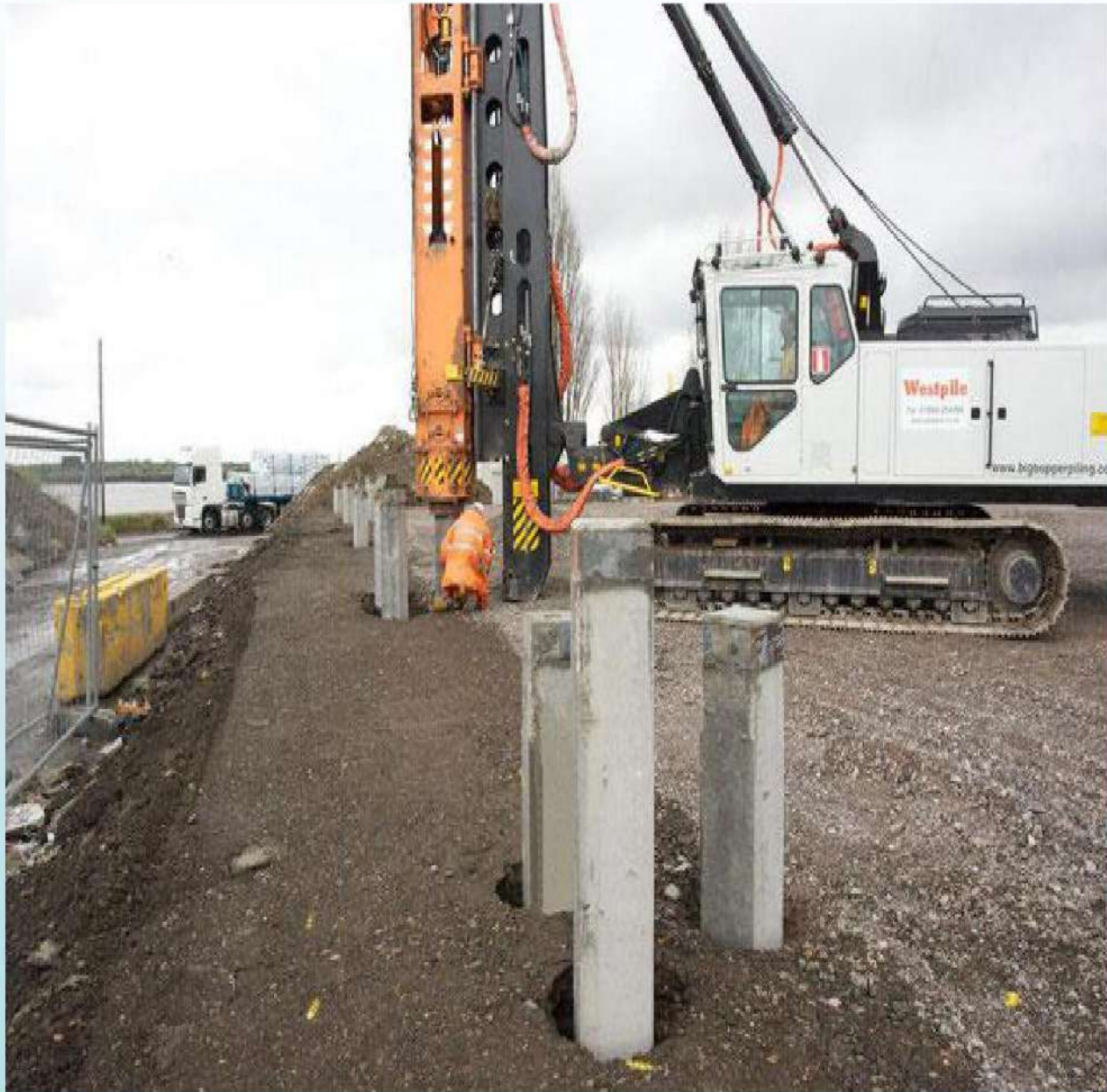
الشكل رقم ( 1 ) يوضح عملية دق الركائز لتقوية التربة تحت الاسس
