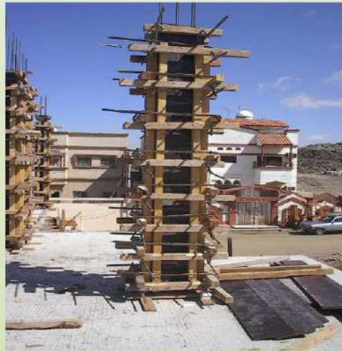
شكل رقم (3) يوضح قالب العمود وكيفية ربط أجزائه
