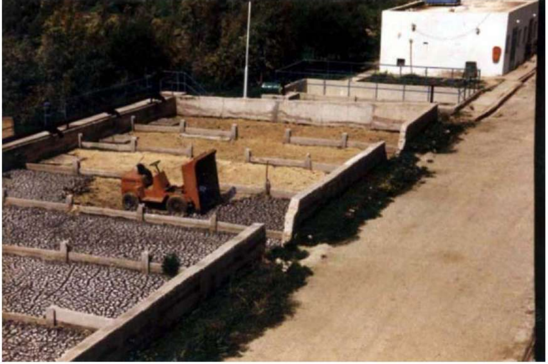
الشكل (3-6) تبين أحواض تجفيف الحمأة
