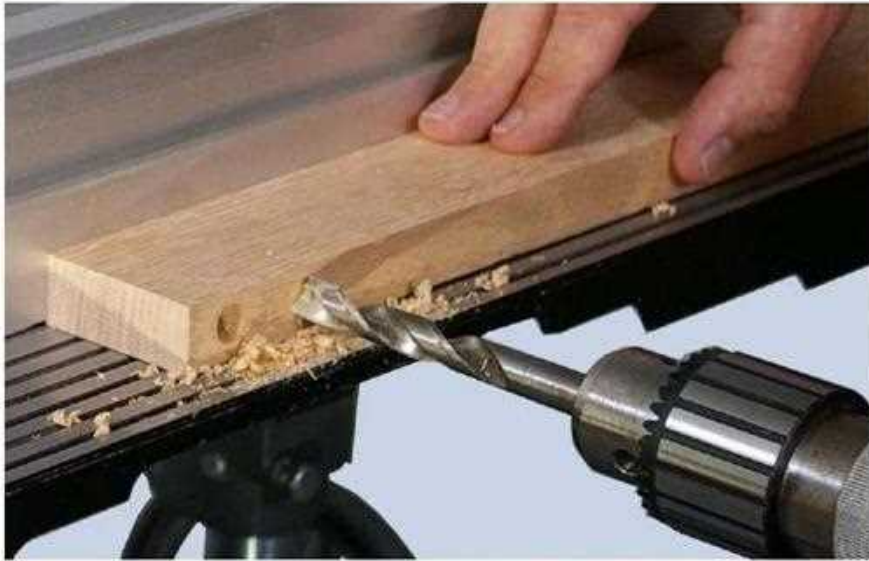
شكل (3 - 79) يوضح عملية النقر
