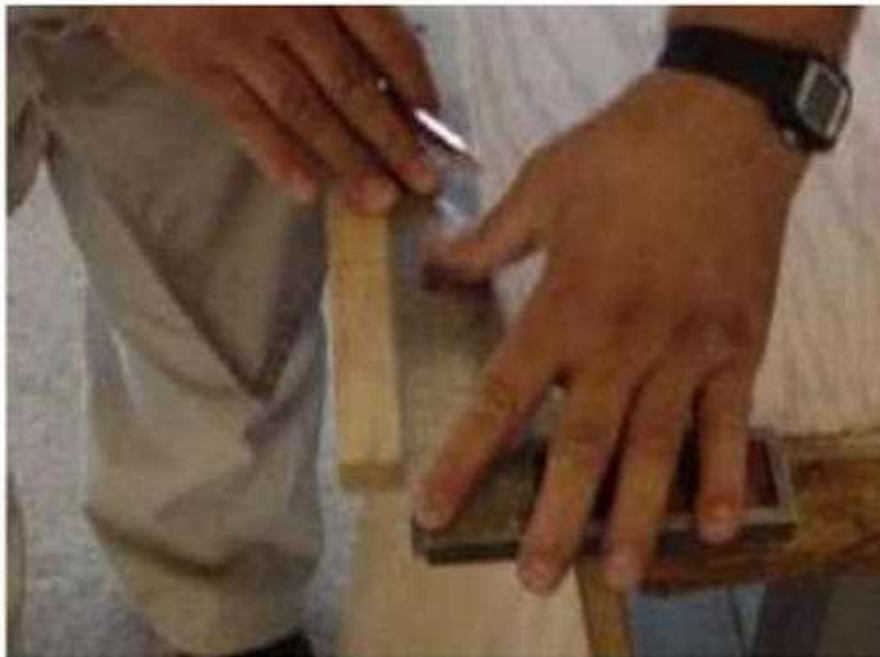
الشكل (3 - 35) يوضح تثبيت مركز المفصلة
