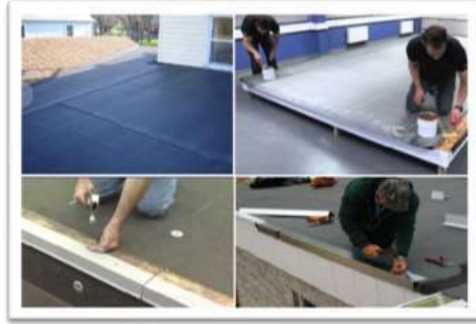
(شكل 3) طريقة العمل بلفائف المطاط
