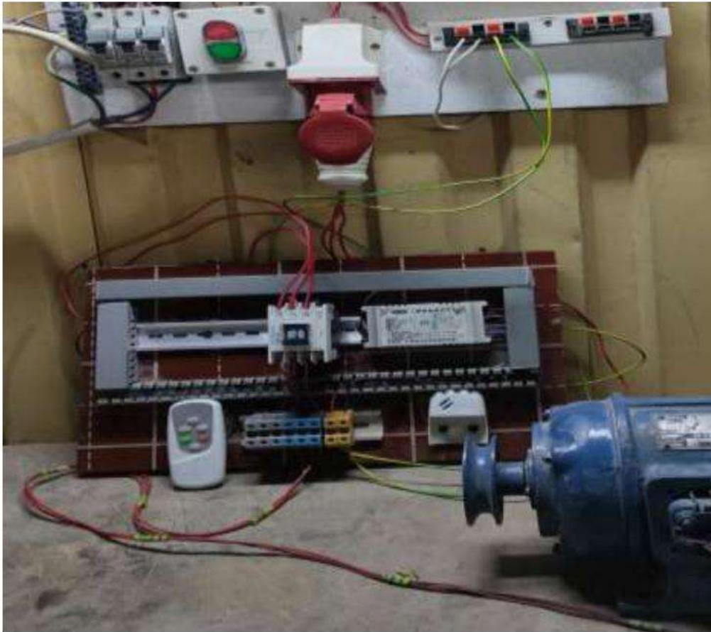
تشغيل محرك ثلاثة اطوار بأستخدام جهاز التحكم عن بعد
