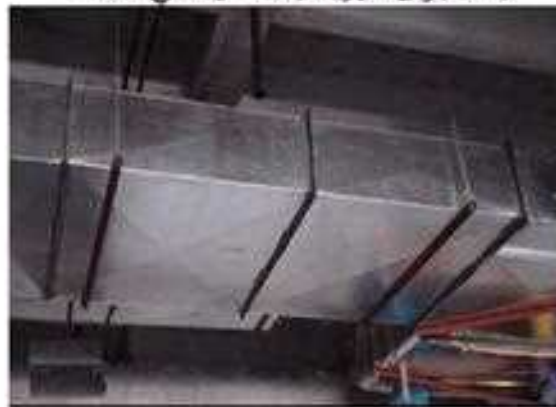
9- مجرى هواء بعد تعليقه في سقف البناية
