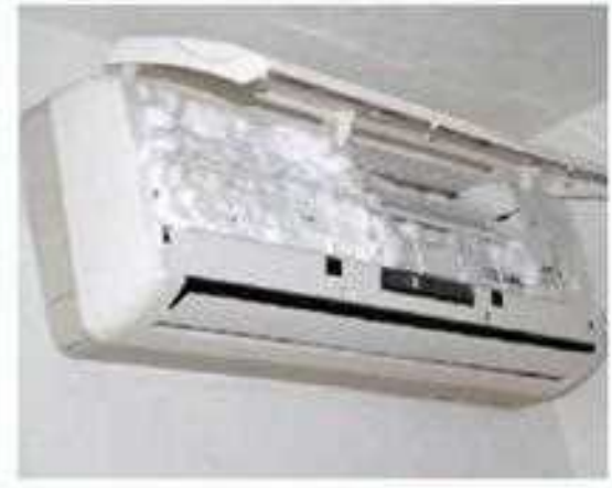
5- غمر المبخر بالمادة الكيميائية
