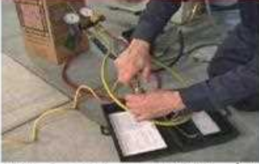
38- ابدأ بعملية الإخواء واربط مقياس ضغط الخواء الإلكتروني
