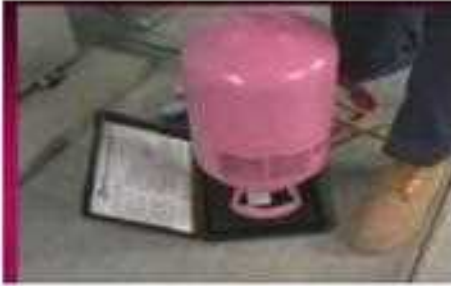
46- إذا كان مانع التثليج R-410A فيجب شحن مانع التثليج بطور السائل
