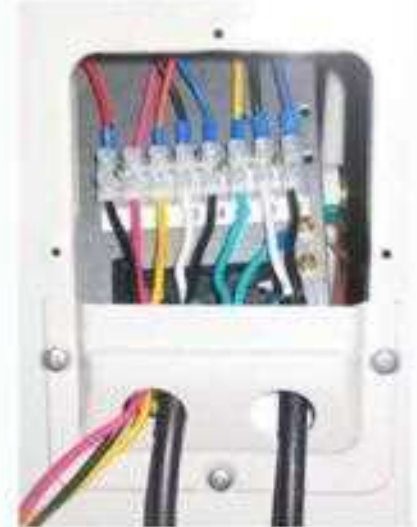
6- ربط الأسلاك الكهربائية للوحدة الخارجية
