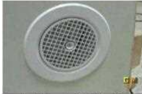
11- ناشرة الهواء بعد تثبيتها
