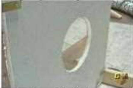
4- الثقب بحسب القطر الخارجي لناشرة الهواء
