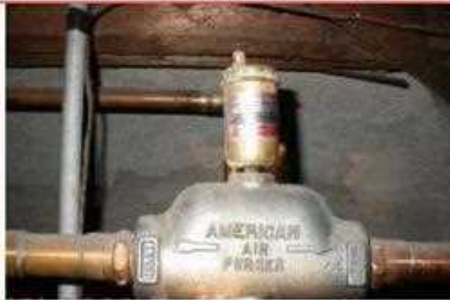
2- طاردة هواء عند صمام ذي اتجاه واحد
