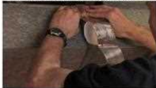
3- استعمل الشريط اللاصق من السطح العلوي لمجرى الهواء
