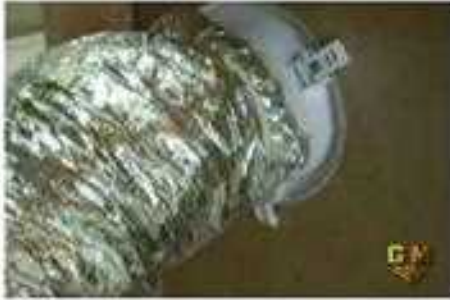
10- مجرى الهواء بعد تثبيته بناشرة الهواء
