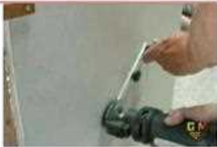
2- استعمال القاطع الكهربائي لقطع الثقب
