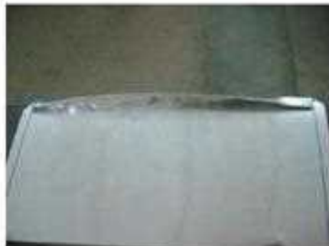
16- الطرق على حافتي وصلة الربط بواسطة مطرقة خشب أو من اللدائن
