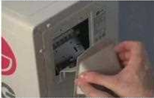
42- أرفع غطاء التوصيلات الكهربائية
