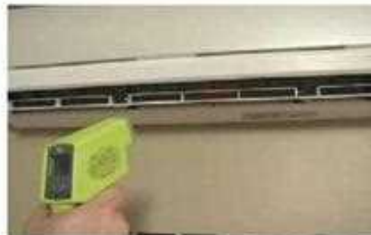
51- قس درجة حرارة المبخر بواسطة محرار الأشعة تحت الحمراء
