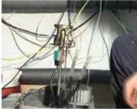
5- انزع الأسلاك الكهربائية
