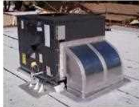
6- تثبيت وحدة التكييف على سطح البناية
