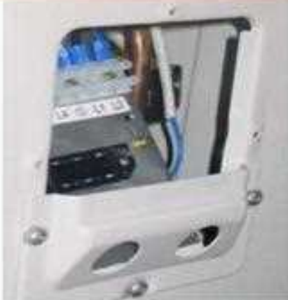
5- أطراف الأسلاك الكهربائية للوحدة الخارجية
