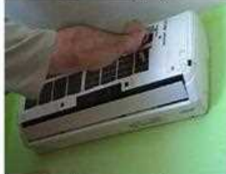
5- أرفع موزعات الهواء
