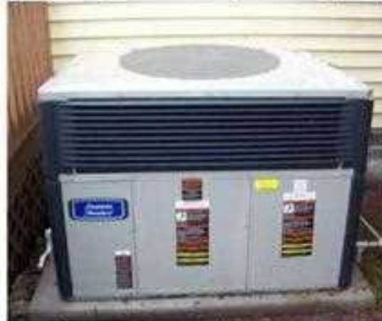
6- وحدة تكييف الهواء المجهزة بعد وضعها على القاعدة الخرسانية
