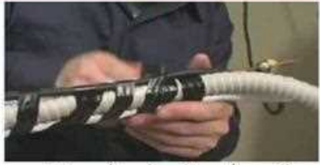
21- جمع أنبوب التصريف والأنبوب النحاسي والأسلاك الكهربائية معاً بواسطة شريط لاصق
