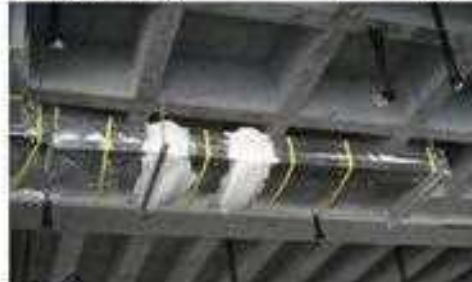
9- مجرى هواء بعد غلق فتحات التسرب فيه
