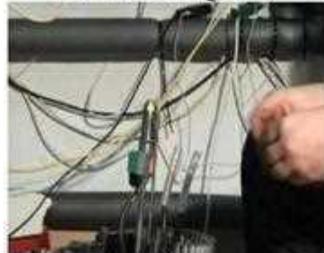
11- نصب النافث الجديد
