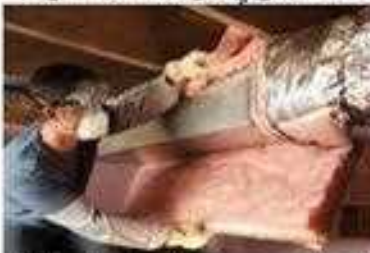
4- لف مجرى الهواء بالعازل
