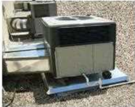
5- تثبيت وحدة التكييف على الأرض
