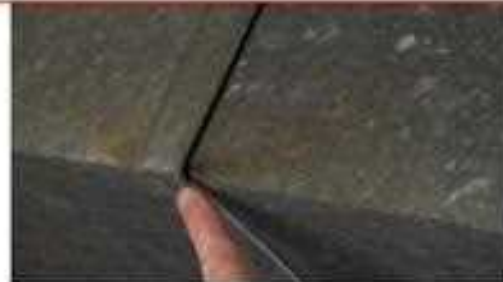
1- مناطق تسرب الهواء من مناطق الربط
