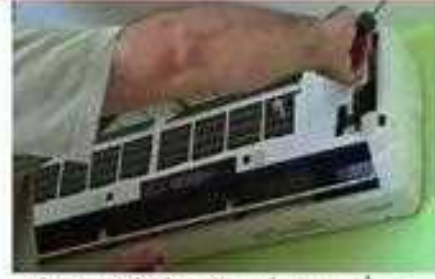
7- أرفع غطاء اللوحة الكهربائية
