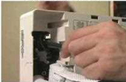
19- تمرير الأسلاك الكهربائية للوحدة الداخلية
