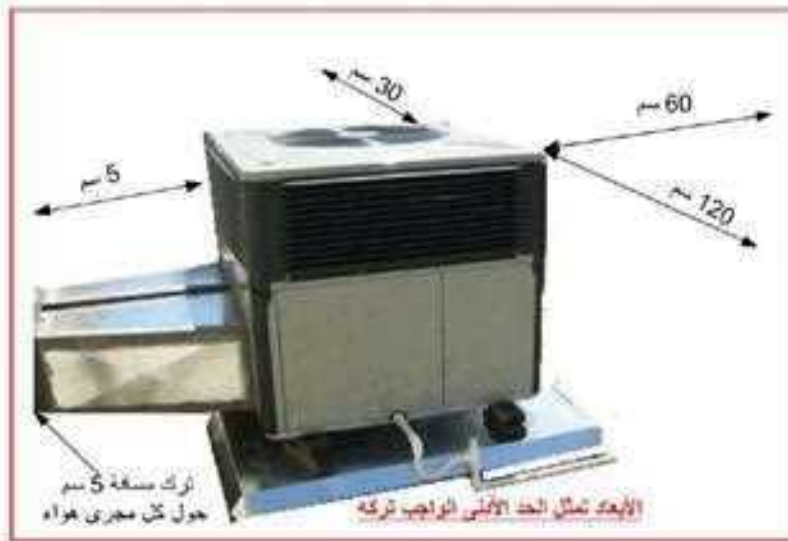
شكل 5-1 الحد الأدنى من الأبعاد الواجب تركها حول وحدة التكييف
