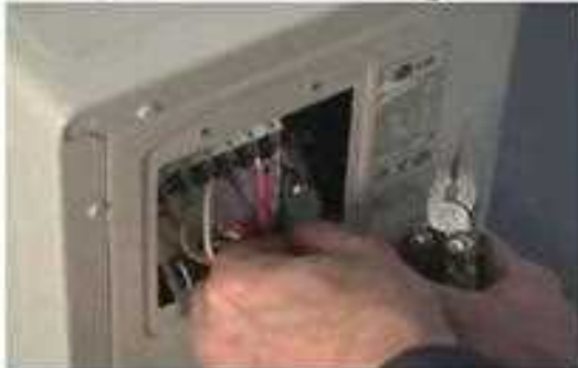
44- أربط أسلاك الوحدة الخارجية بالوحدة الداخلية
