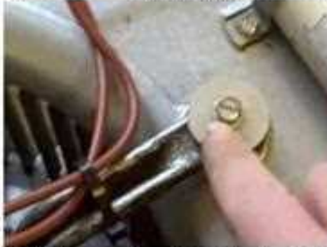
7- لولب تثبيت المحرك بجسم النافخ
