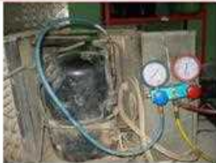
1- ربط أسطوانة مانع التثليج بالأنبوب الأصفر 2- ربط مقياس صمام الخدمة بالأنبوب الأزرق
