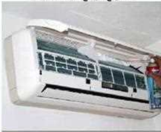
4- رش المادة الكيميائية على مبخر الوحدة الداخلية
