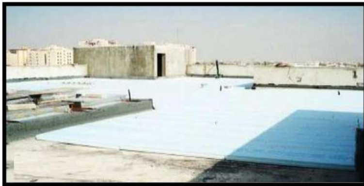
شكل (9-3) يوضح اللباد كعازل حراري للمباني
