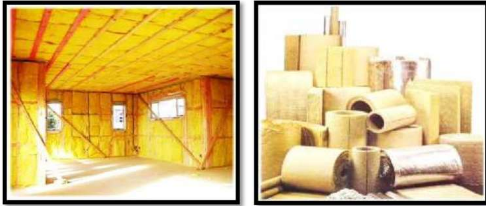
شكل (6-9) يوضح الصوف الزجاجي كعازل للصوت للسقوف والجدران
